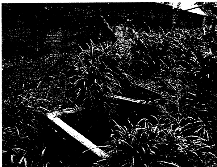
Foto 10: Obras de canalização do rio obstruídas e mal dimensionadas(?) e muro com escoras de concreto.
