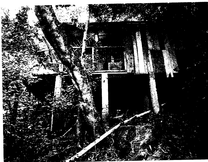
Foto 7: Casa de alta vulnerabilidade construída sobre bloco solto.
