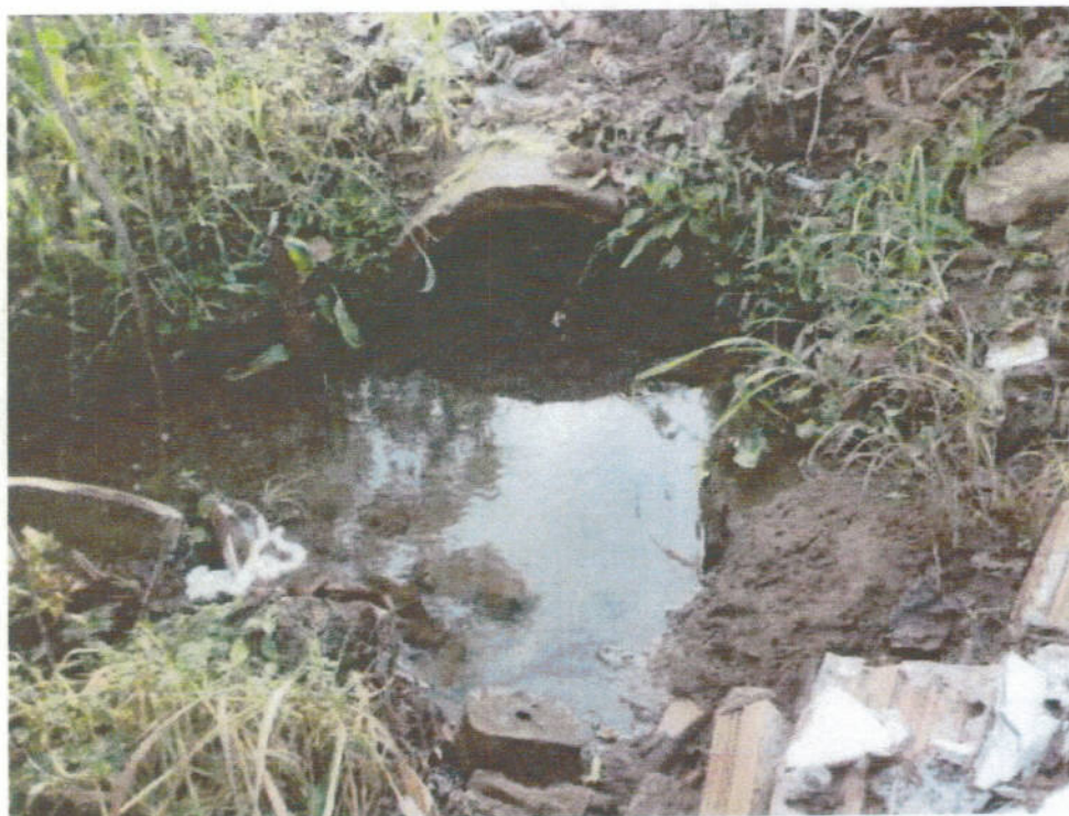
FOTO 03 – Local da descarga das águas canalizadas embaixo das ruas e moradias,
