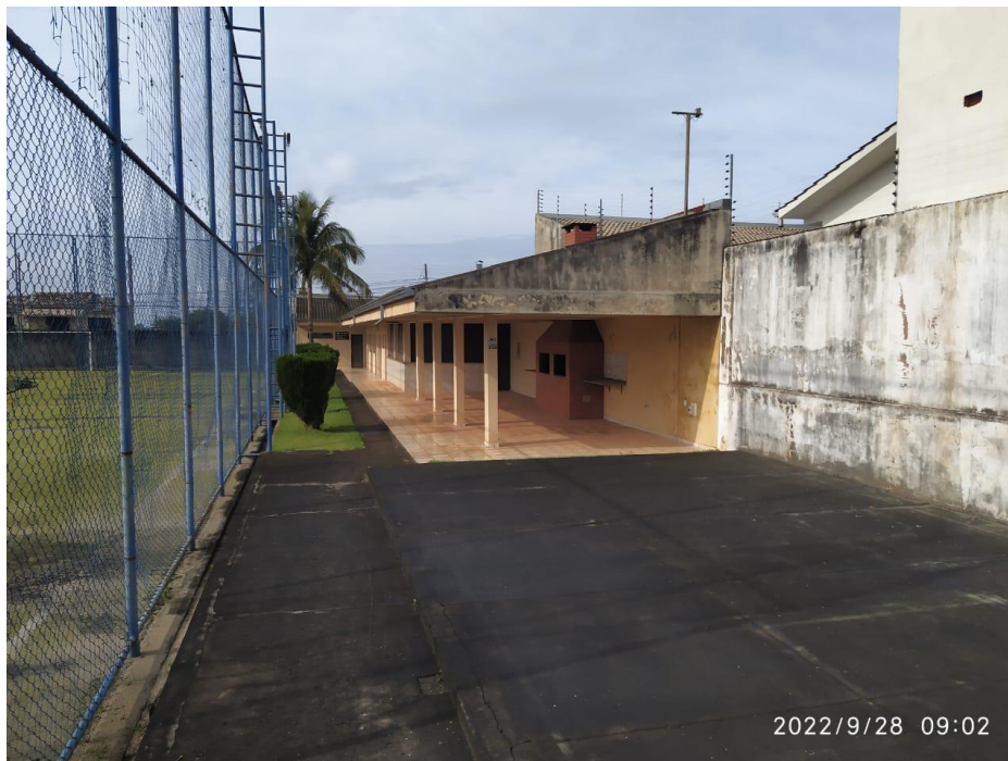
Figura 1 - Edificação em Alvenaria
