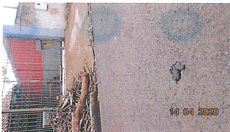
Figura 1 – Material betuminoso desprendido
