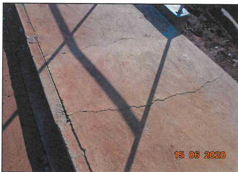
Figura 5 - Fissuras no passeio a jusante
