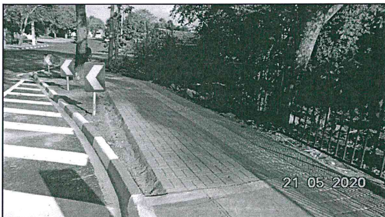
Figura 11 - Passeio em piso intertravado e podotátil.
