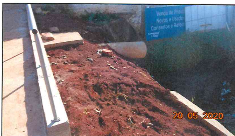
Figura 13 - Saída da boca de lobo com tubo em concreto.
