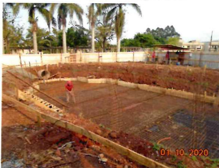
Figura 5 - fundação para execução de radier
