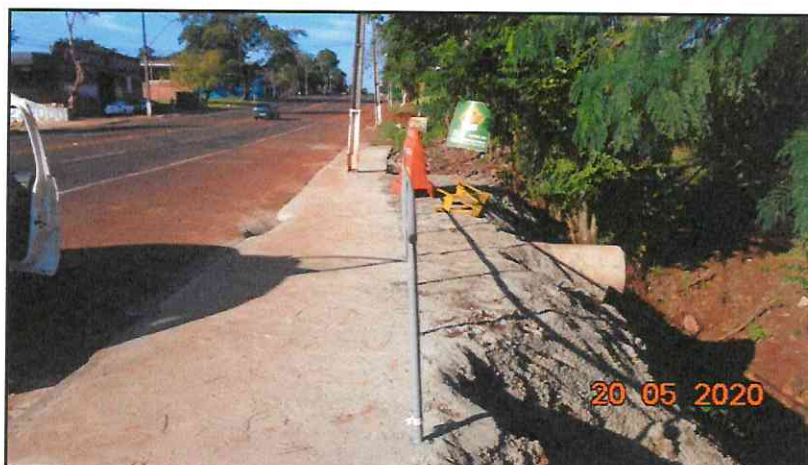
Figura 4 - Passeio executado em concreto.
