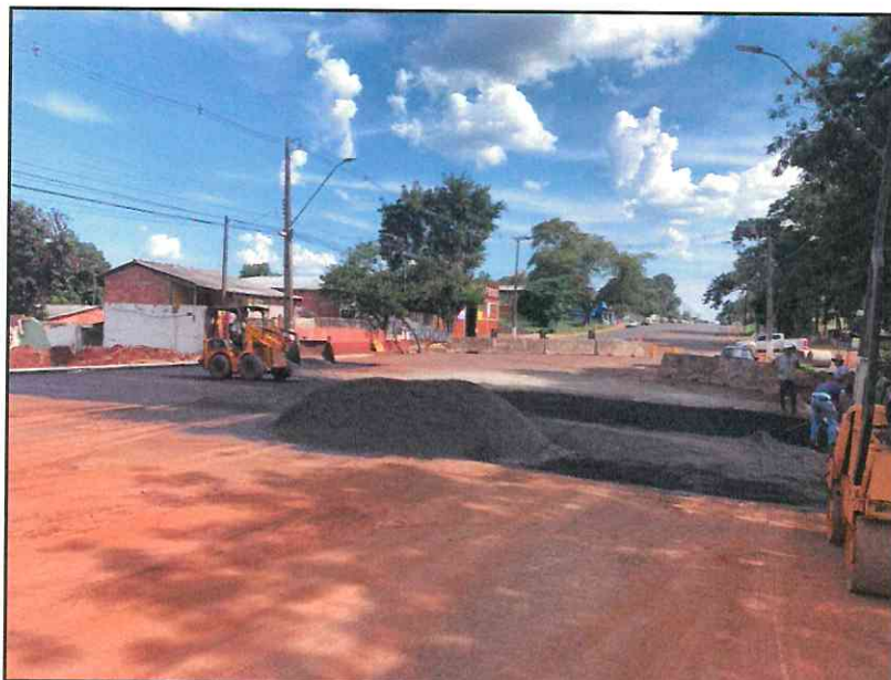
Figura 10 - Material para recomposição asfáltica.
