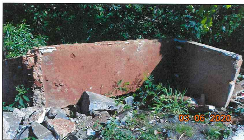
Figura 6 - Parte danificada da aduela existente.
