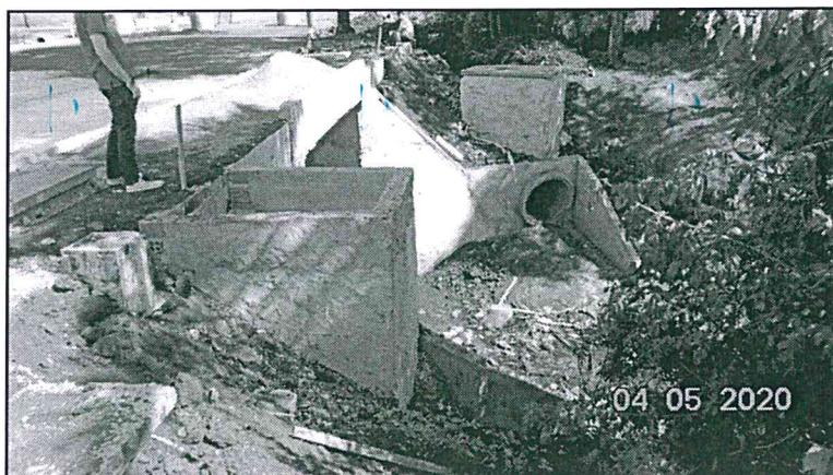
Figura 9 - Caixa de ligação e passagem.
