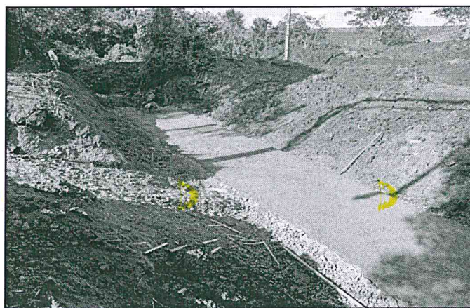
Figura 3 - Regularização de base em concreto.
