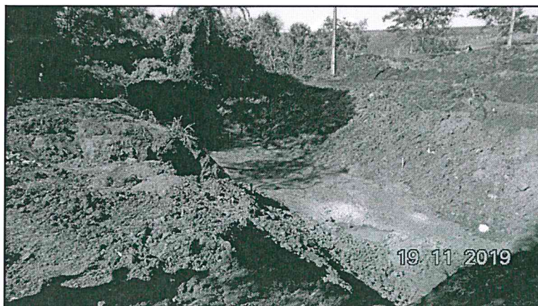
Figura 2 - Corte de solo para instalação da aduela.
