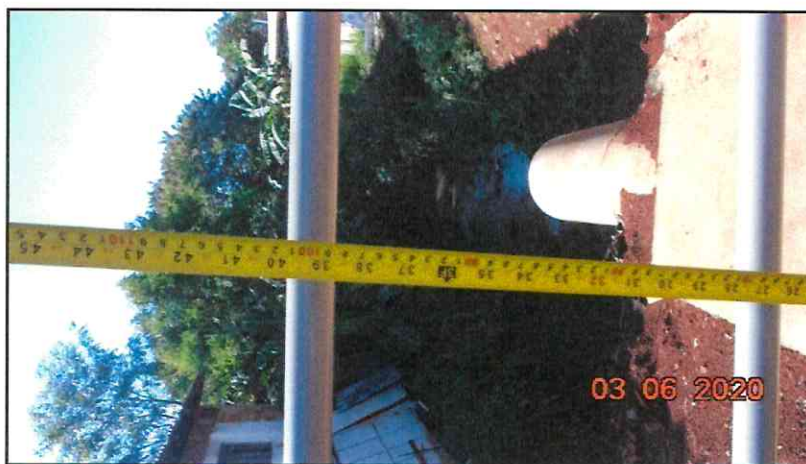
Figura 3 – Guarda-corpo executado com altura de 100 cm.
