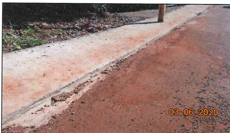
Figura 11 - Meio-fio não executado.
