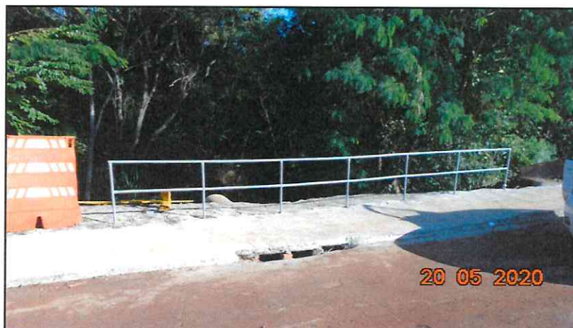
Figura 1 - Guarda-corpo executado.
