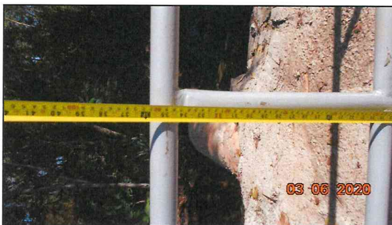
Figura 2 – Guarda-corpo executado com altura de 90 cm.
