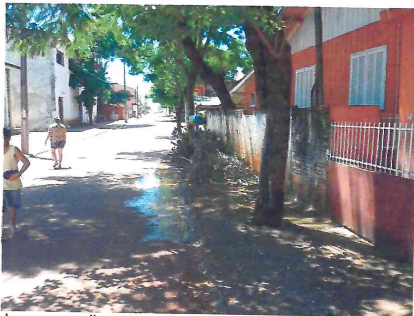
drenagem e limpeza na Rua Alverina Dias
