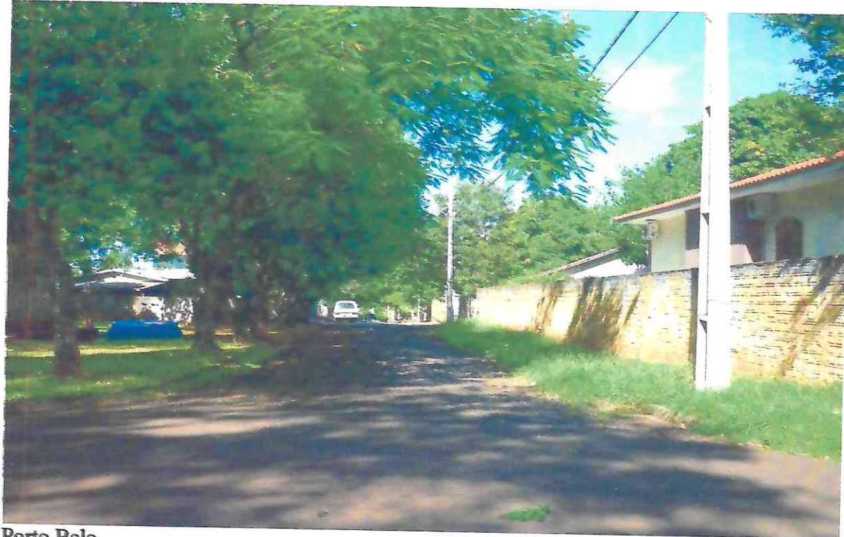
Porto Belo Pavimentação de Asfalto Rua: Inácio Dotto
