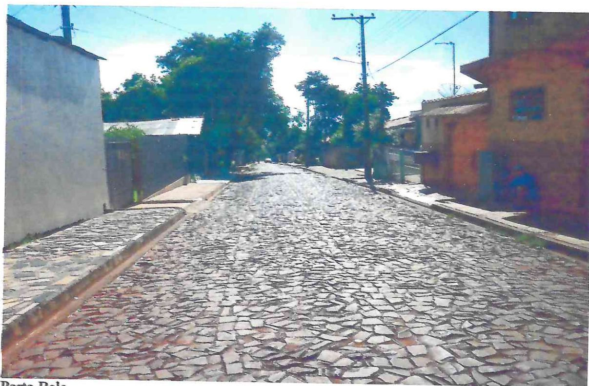
Porto Belo Pavimentação de Asfalto Rua: Prudêncio Sotelo
