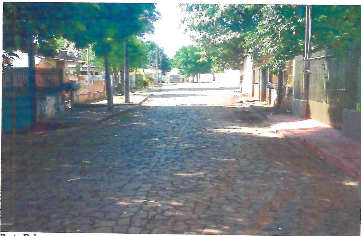
Porto Belo Pavimentação de Asfalto Rua: Olga Royer
