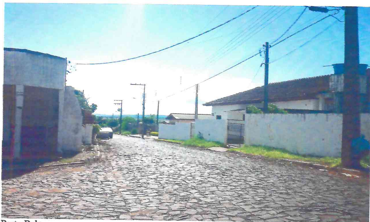
Porto Belo Pavimentação de Asfalto Rua: Diosnel Saldivar
