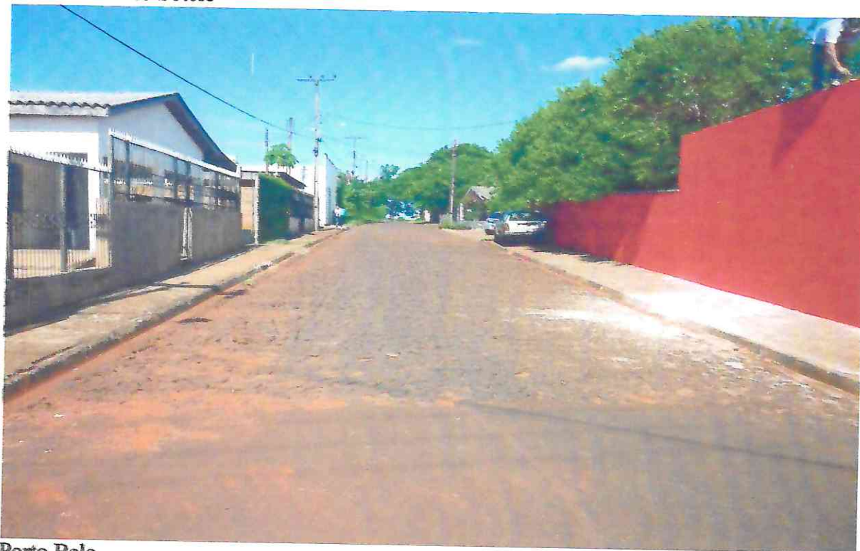
Porto Belo Pavimentação de Asfalto Rua: Prudêncio Sotelo
