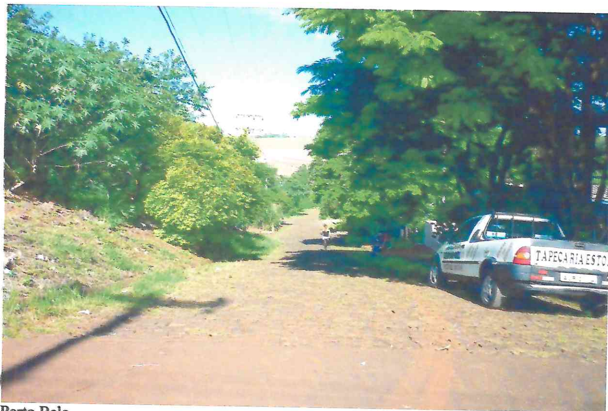
Porto Belo Pavimentação de Asfalto Rua: Ramão Nascimento
