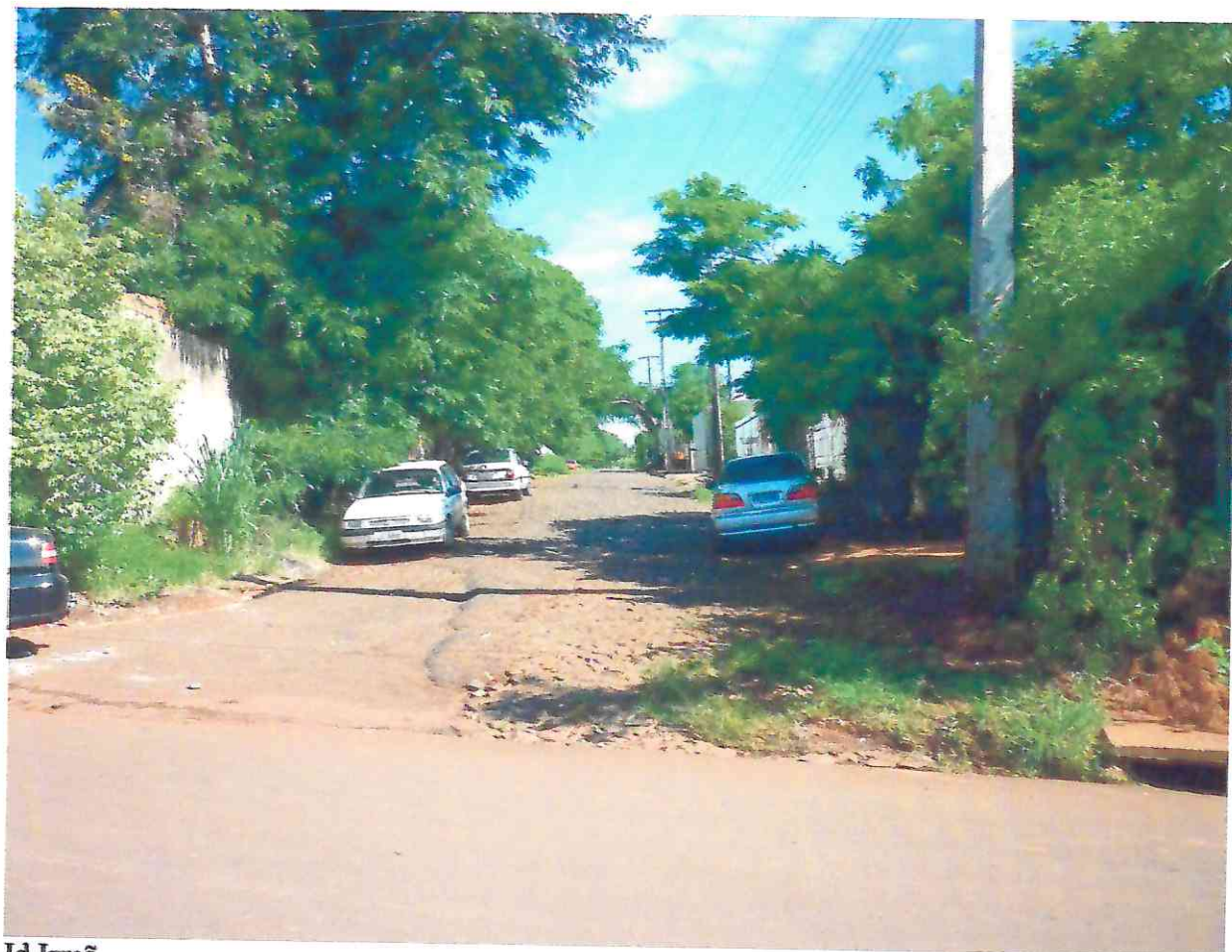
Jd Irmã Pavimentação de Asfalto Rua: Rosângela da Silva
