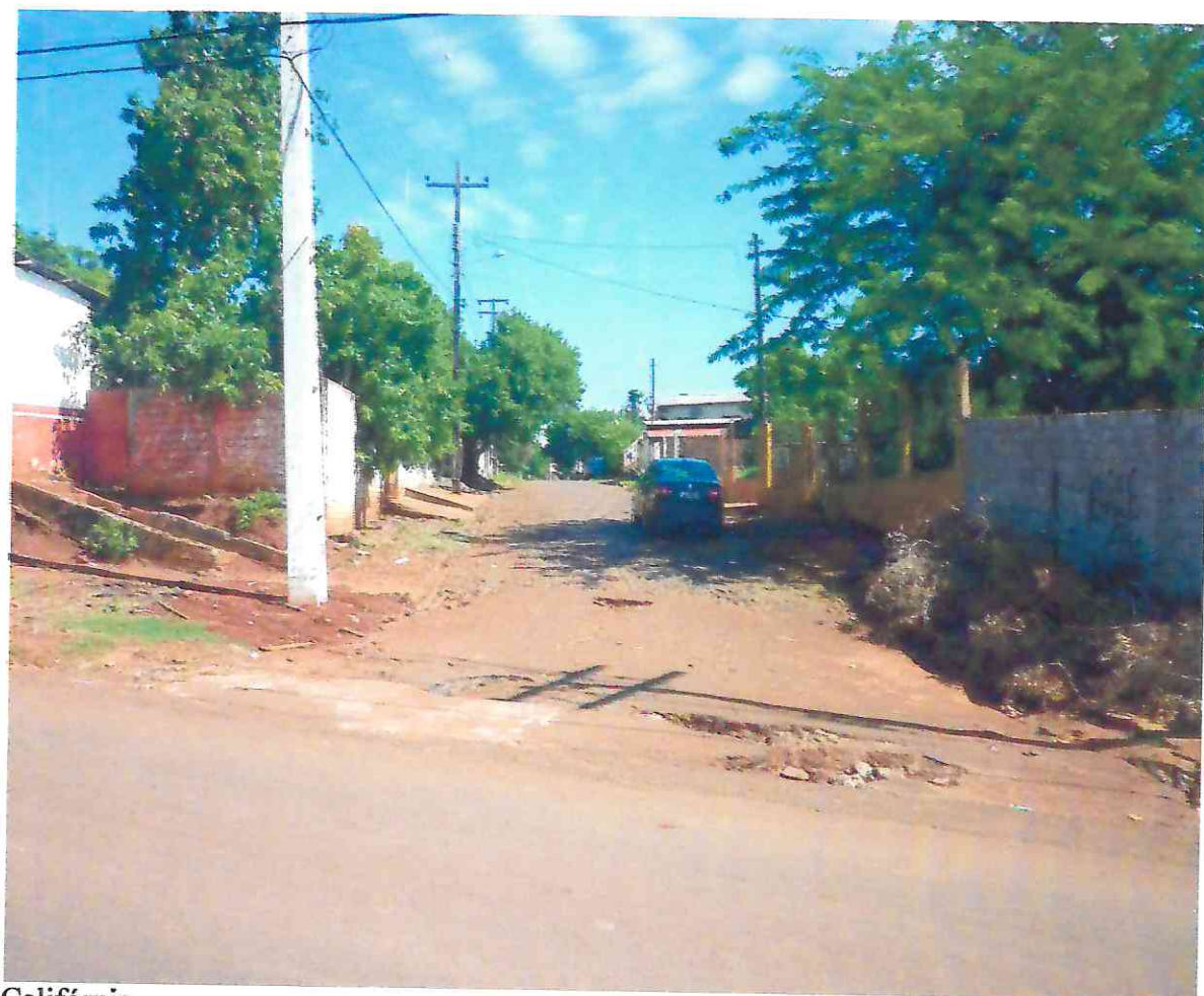
Califórnia Pavimentação de Asfalto. Rua: Matsuko Mertz
