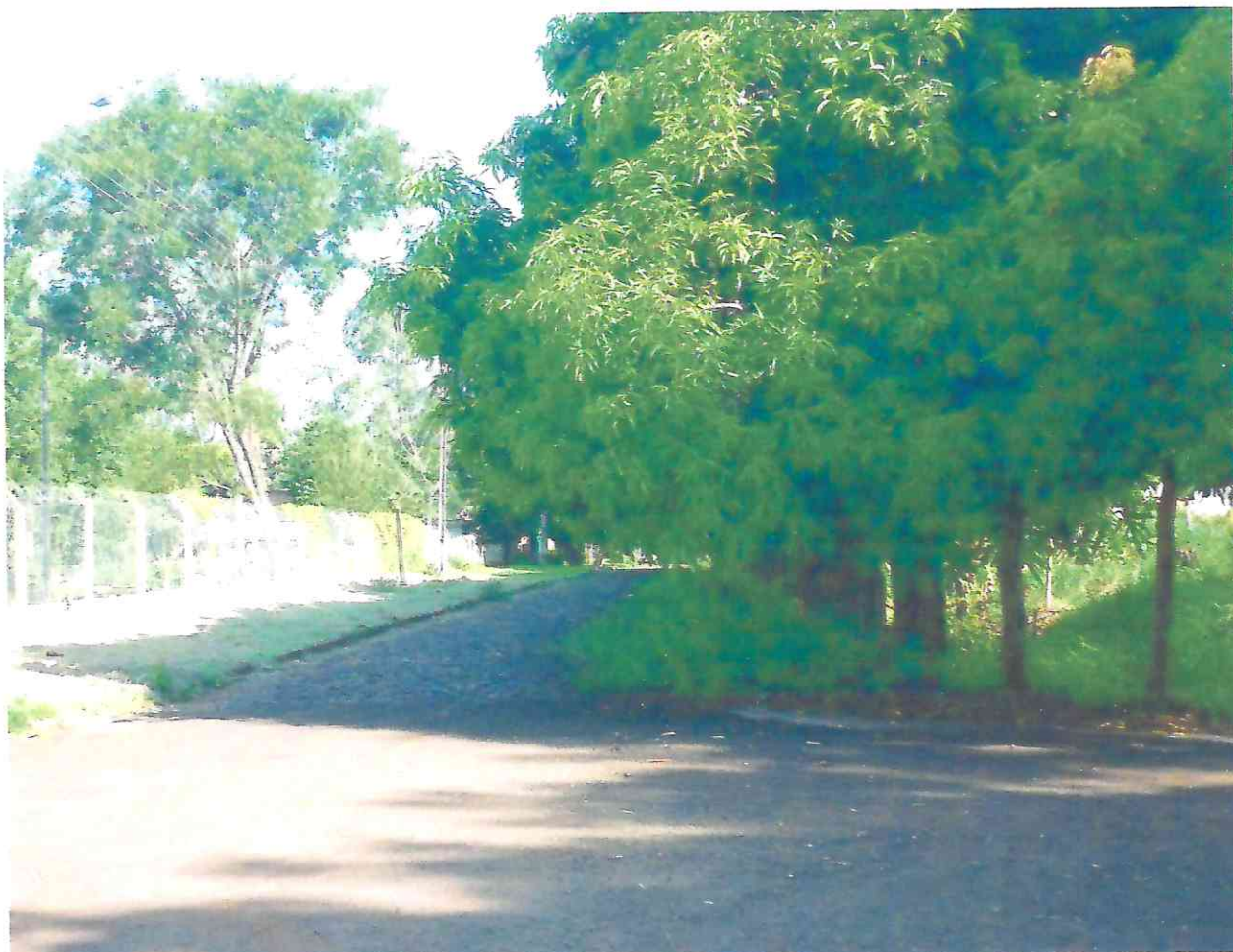
Porto Belo Poda das Arvores e limpeza da rua. Rua: Ana Dotto Sotelo
