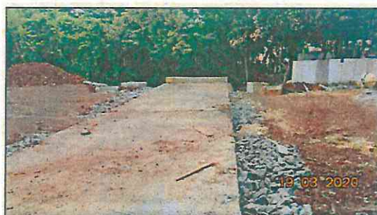
Figura 16 – Drenagem e preparação para pavimento
