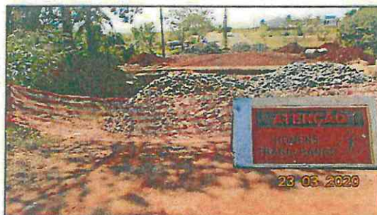
Figura 2 – Isolamento do canteiro
