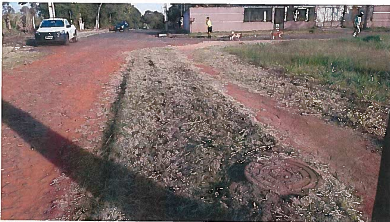
Foto 03 – Tampa de ferro de Poço de visita – Rua das Tulipas x Rua Jatobá
