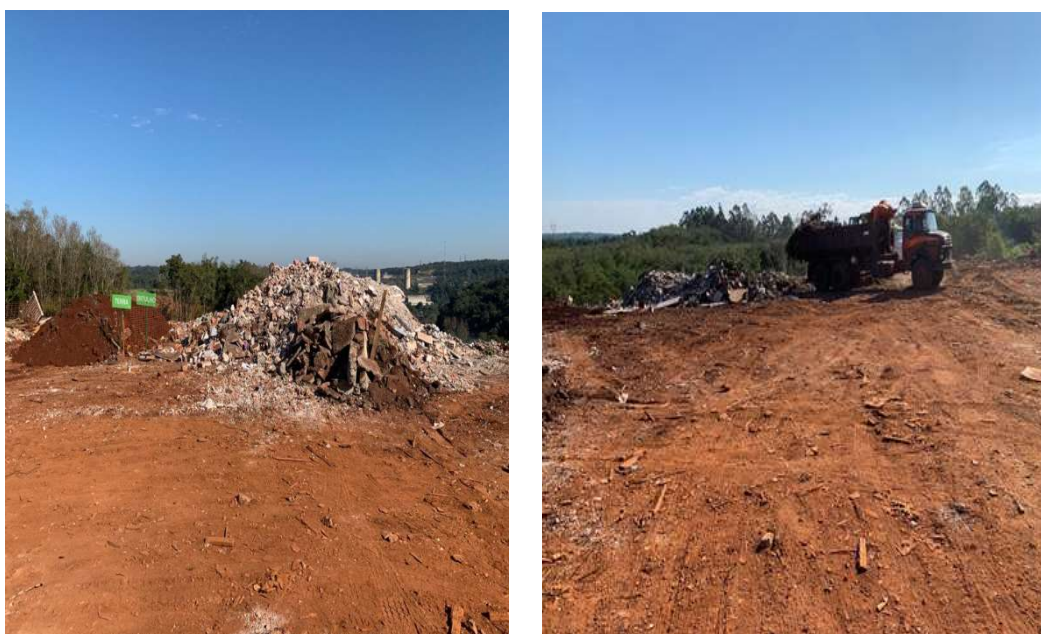
Fotos do Pátio de Resíduos da Construção Civil e Volumosos
