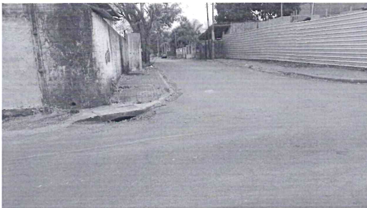
Rua Matelândia - foto 2:
