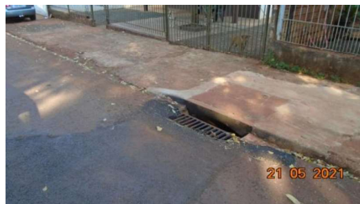
Figura 20 – Pintura do meio fio e guia chapéu da BLS (Rua Pilar)
