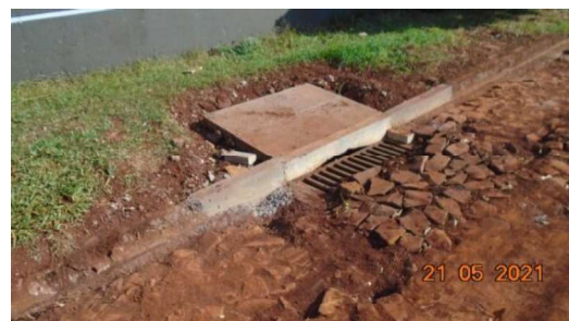
Figura 26 – Reconformação do poliedro ao redor da grelha da BLS (Rua Cianorte)
