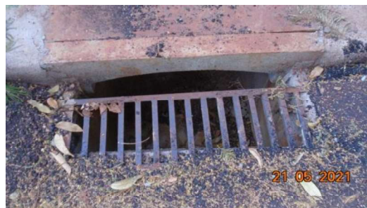
Figura 14 – Limpeza interna da BLS (Rua Pilar)
