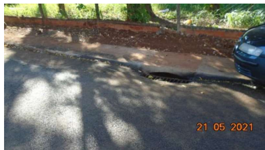
Figura 22 – Pintura do meio fio e guia chapéu da BLS (Rua Pilar)
