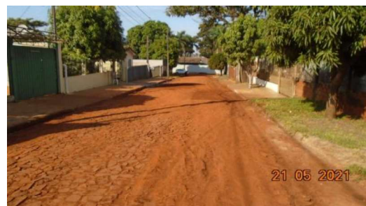
Figura 30 – Limpeza do pavimento (Rua Cianorte)
