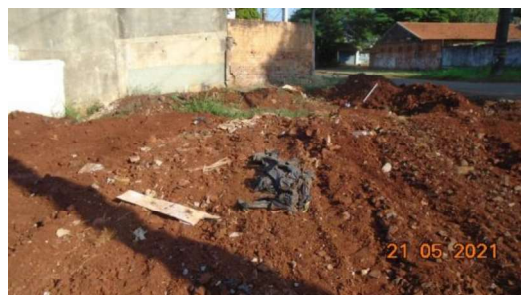
Figura 10 – Retirada do entulho e espalhamento e nivelamento de material (Rua Dr. Moacir Azambuja)
