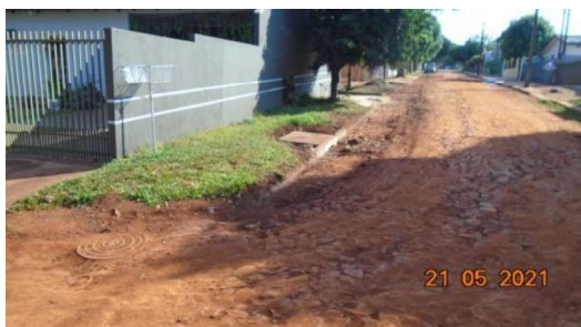
Figura 25 – Recomposição do pavimento executado (Rua Cianorte)
