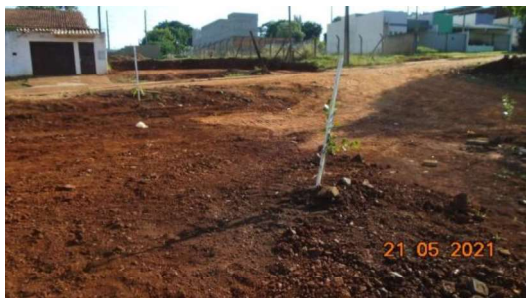
Figura 1 – Melhorar o nivelamento do terreno e espalhamento do material remanescente (Rua Eldorado)
