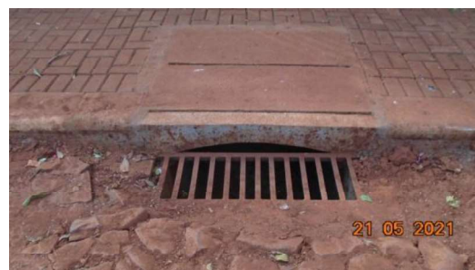
Figura 42 – Reconformação do poliedro ao redor da grelha da BLS (Rua Jacanga)
