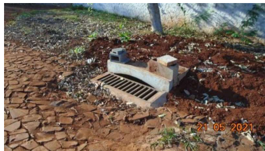
Figura 4 – Melhorar acabamento da calçada com paver (Rua Eldorado)
