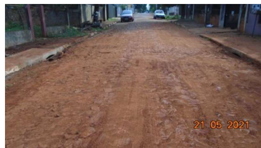
Figura 40 – Limpeza do pavimento (Rua Iacanga)
