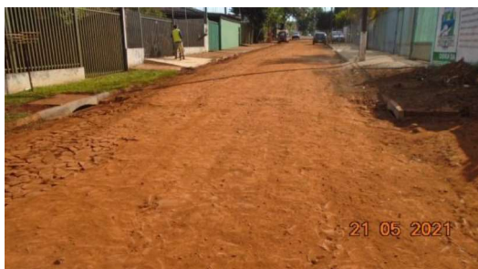
Figura 37 – Limpeza do pavimento (Rua Jacanga)
