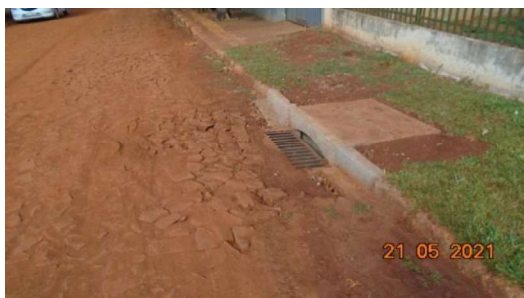
Figura 39 – Reconformação do poliedro ao redor da grelha da BLS (Rua Jacanga)
