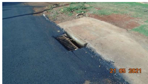
Figura 6 – Acabamento em recomposição asfáltica (Rua Guaratinguetá)
