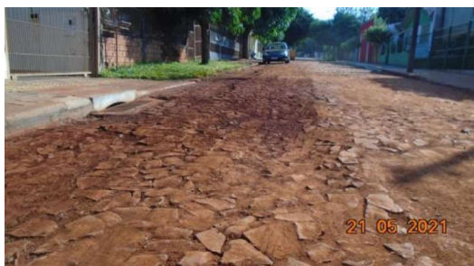
Figura 29 – Recomposição do pavimento (Rua Cianorte)
