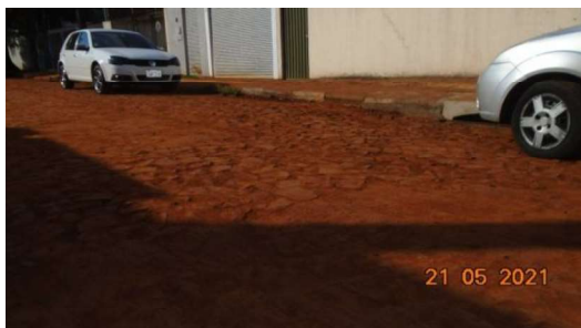
Figura 23 – Recomposição do pavimento executado (Rua Cantagalo)
