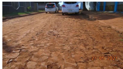
Figura 24 – Recomposição do pavimento executado (Rua Cantagalo)
