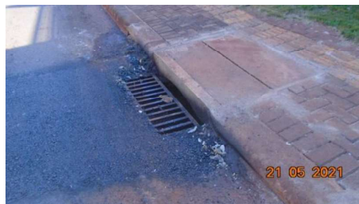
Figura 8 – Pintura da guia chapéu da BLS e meio fio (Rua Guaratinguetá)
