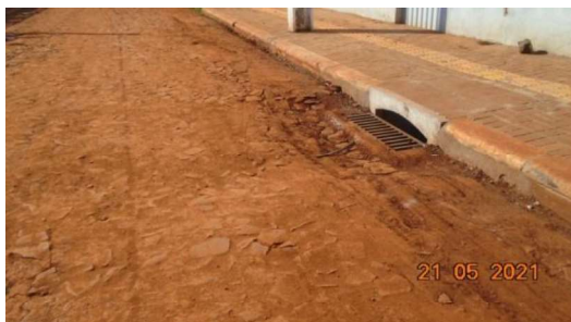
Figura 31 – Reposição do pavimento (Rua Cantagalo)
