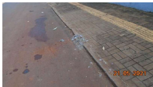
Figura 18 – Recomposição do meio fio danificado (Rua Sobradinho)
