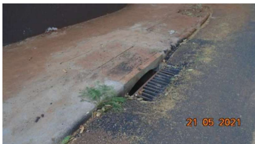
Figura 13 – Pintura da guia chapéu da BLS (Rua Pilar)
