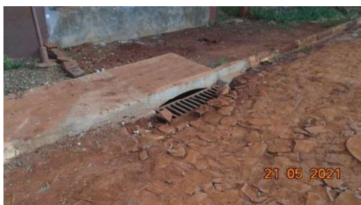
Figura 41 – Reconformação do poliedro ao redor da grelha da BLS (Rua Iacanga)
