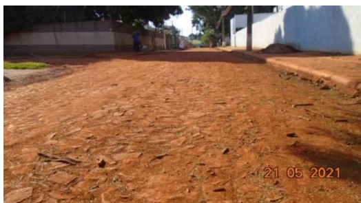
Figura 33 – Limpeza do pavimento (Rua Cantagalo)
