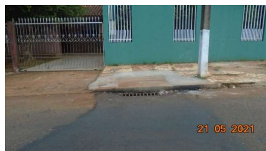
Figura 44 – Aumentar o recebimento da guia chapéu da BLS e Pintura da Guia e do Meio fio (Rua Pilar)
