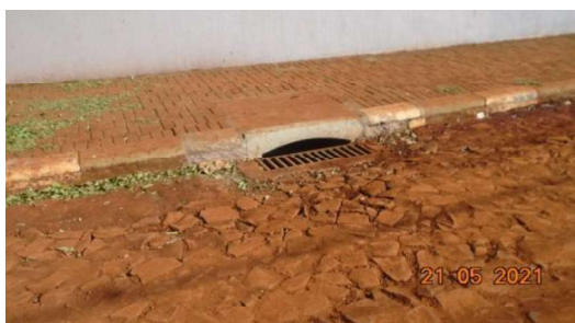
Figura 35 – Reconformação do poliedro ao redor da grelha da BLS (Rua Cantagalo)
