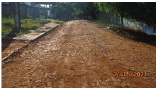
Figura 3 – Limpeza do pavimento (Rua Eldorado)
