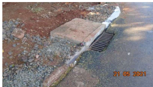
Figura 12 – Nivelar o meio fio a altura da guia chapéu da BLS e calçada em paver (Rua Pilar)
