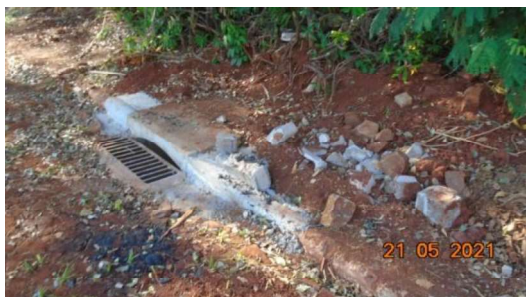
Figura 5 – Retirada de material excedente e regularização do entorno da BLS e acabamento com paver (Rua Eldorado)
