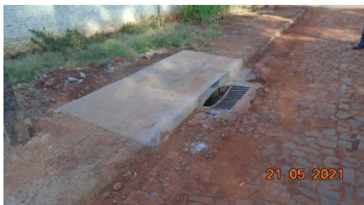
Figura 11 – Substituição da grelha e melhorar a compactação do poliedro (Rua Dr. Moacir Azambuja)
