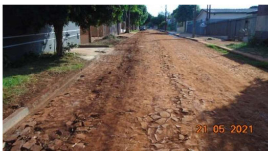
Figura 27 – Recomposição do pavimento executado (Rua Cianorte)
