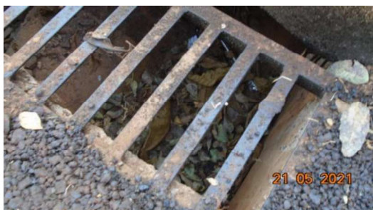
Figura 9 – Limpeza interna da BLS (Rua Guaratinguetá)
