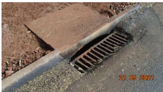
Figura 15 – Pintura do meio fio e da guia chapéu de BLS (Rua Pilar)
