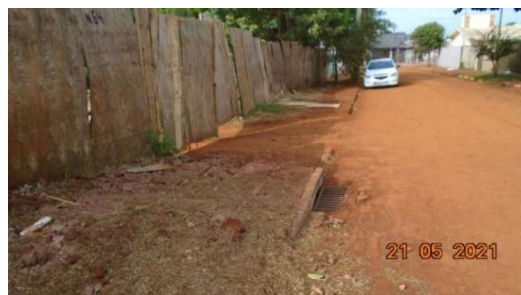
Figura 38 – reposição do meio fio e regularização do acesso (Rua Jacanga)
