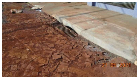
Figura 32 – Reconformação do poliedro ao redor da grelha da BLS (Rua Cantagalo)
