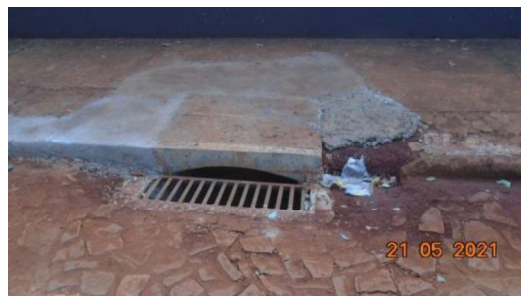
Figura 16 – Recomposição do meio fio (Rua Navegantes)
