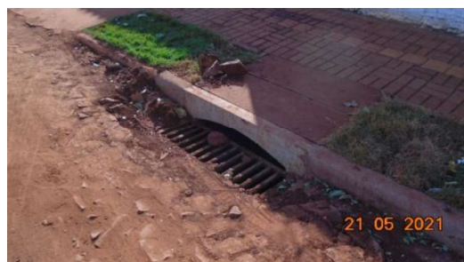
Figura 36 – Reconformação do poliedro ao redor da grelha da BLS (Rua Jacanga)
