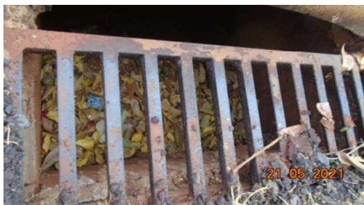
Figura 21 – Limpeza interna da BLS (Rua Pilar)
