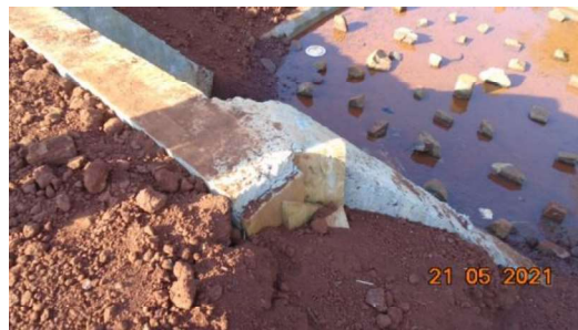
Figura 2 – Retirada das formas das alas (Rua Eldorado)
