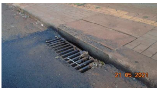
Figura 43 – Aumentar o recebimento da guia chapéu da BLS e Pintura da Guia e do Meio fio (Rua Pilar)
