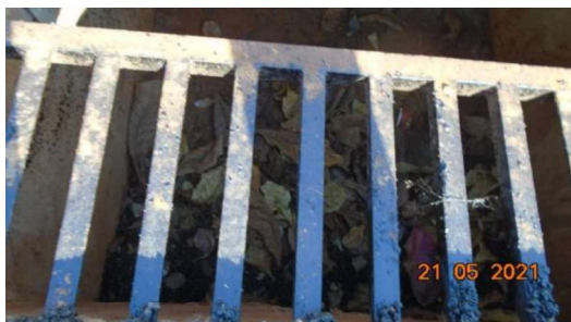
Figura 7 – Limpeza interna da BLS (Rua Guaratinguetá)
