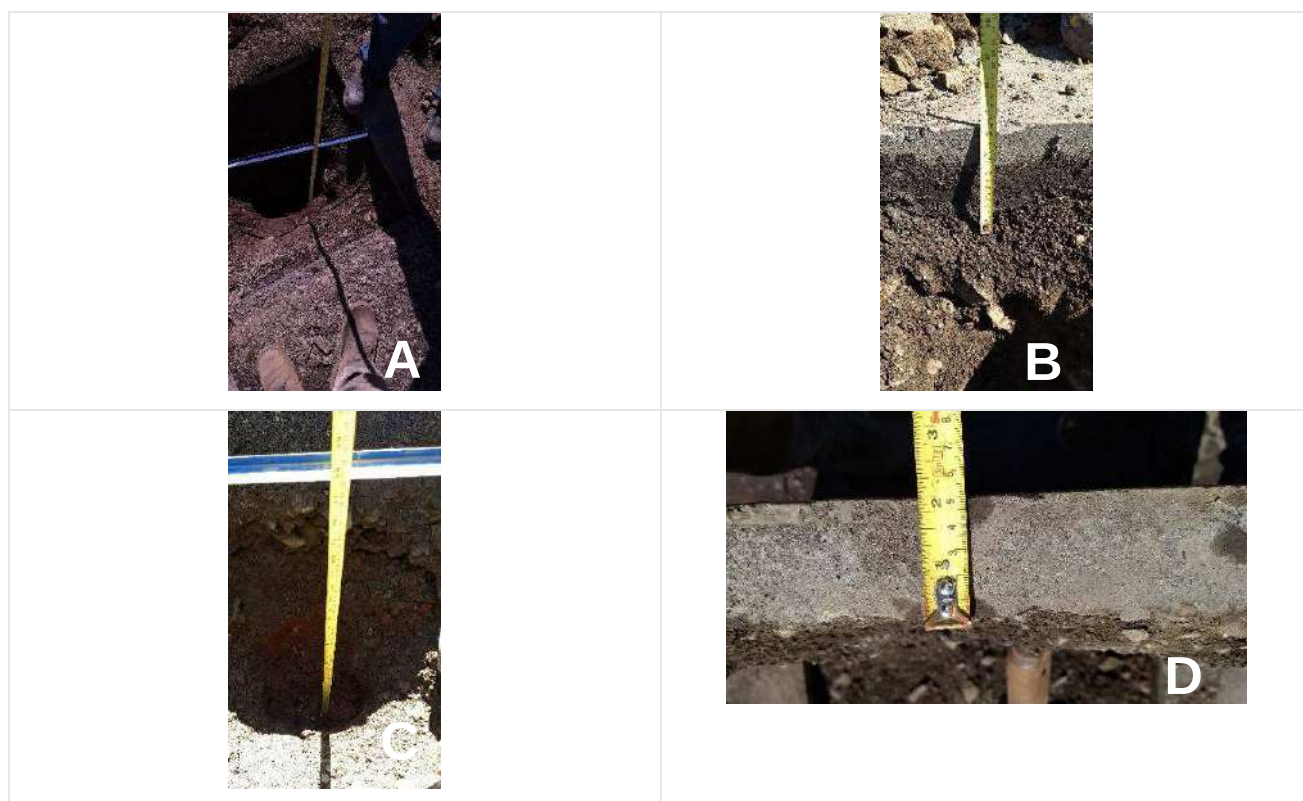
FOTO 03: Rua Morenitas - Poço de Inspeção (Cava de Inspeção) – PI-03
