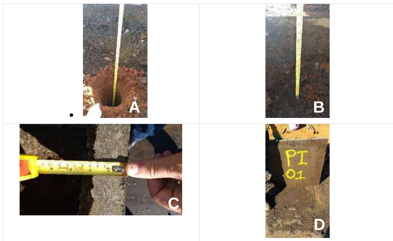
FOTO 01: Rua Morenitas - Poço de Inspeção (Cava de Inspeção) – PI-01
