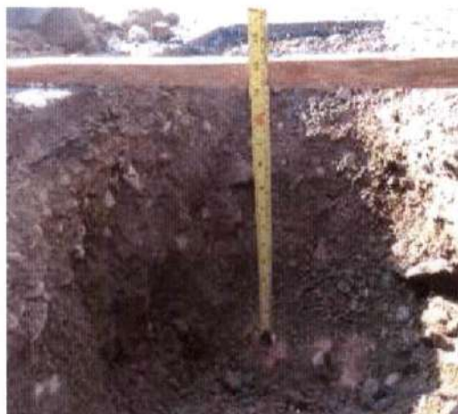
Figura 15 – Medição de camada de sub-base, base e capa, no ponto PT2.
