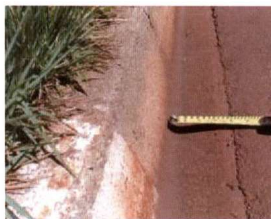
Figura 19 – Medição da largura interna (10cm).
