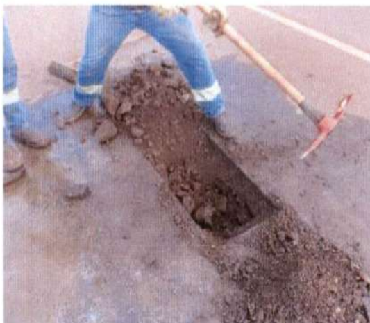
Figura 14 – Abertura de trincheira na pista sul, na Av. Morenitas, no ponto MN3.
