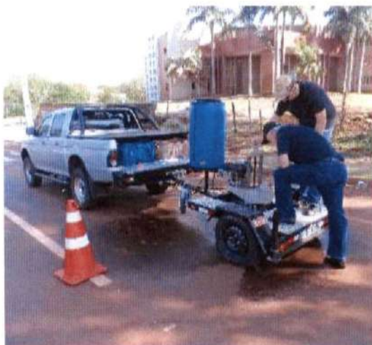
Figura 10 – Realização de furo na Av. Portugal.
