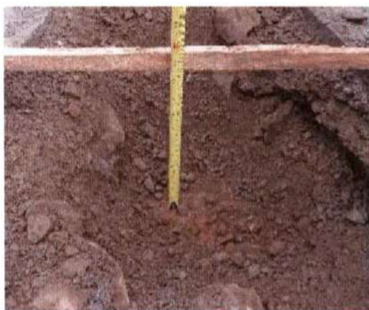
Figura 16 – Medição de camada de sub-base, base e capa, no ponto MN1.
