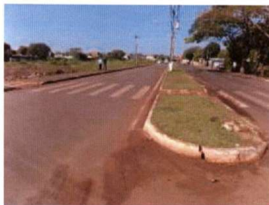
Figura 06 – Trecho final da Av. Javier Koelbl, com pista nova à esquerda.
