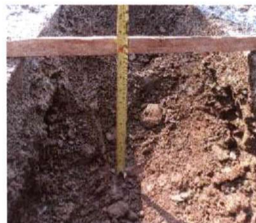
Figura 17 – Medição de camada de sub-base, base e capa, no ponto MN4.
