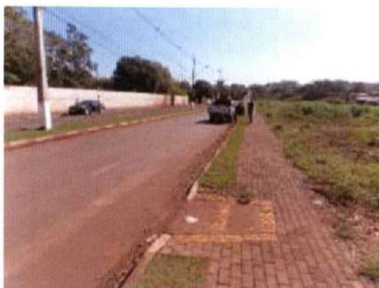
Figura 05 – Trecho inicial da Av. Javier Koelbl, com pista nova à direita.
