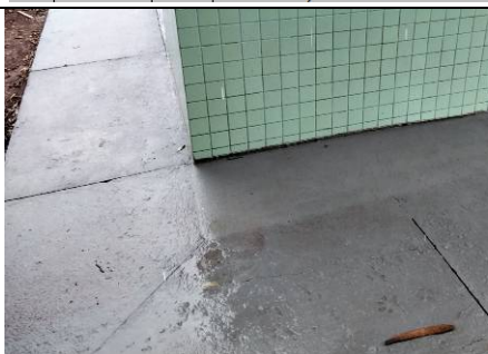
6.2.2 Pintura acrílica em calçada externa
