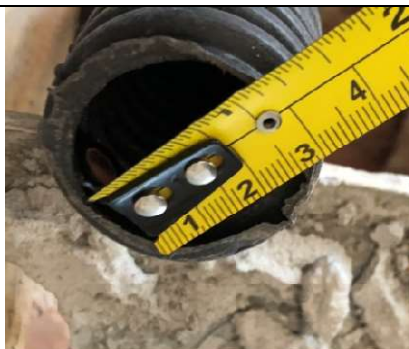
2.1.12 Eletroduto flexível DN 32mm
