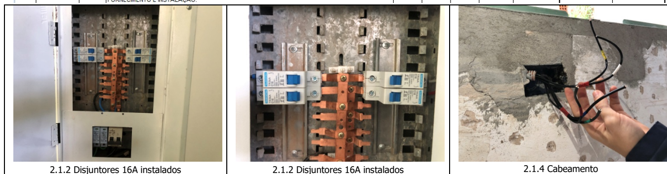
2.1.2 Disjuntores 16A instalados
