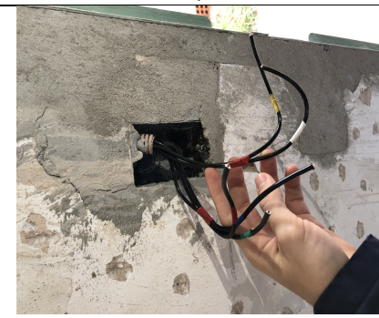
2.1.11 Eletroduto flexível DN 25mm (embutido)
