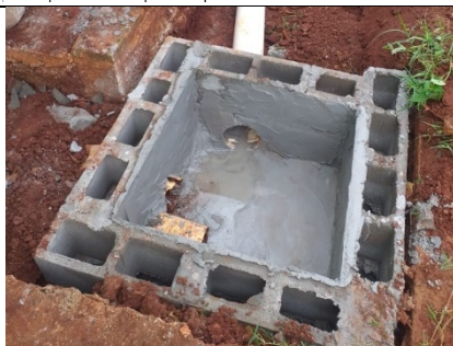
3.2.23 Caixa hidráulica em blocos de concreto
