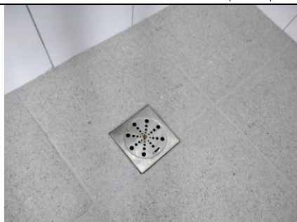
3.2.21 Caixa sifonada com grelha de aço
