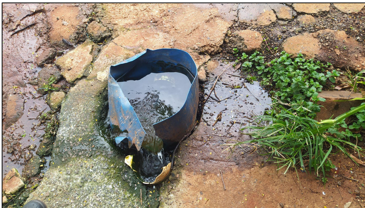
Estrutura construída por moradores da área para o direcionamento da água, localizada nas proximidades da Rua Noruega, 378.
