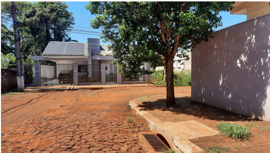
Figura 3 – Esquina da Rua Jacanga com Rua Cantagalo, pavimento sujo com solo
