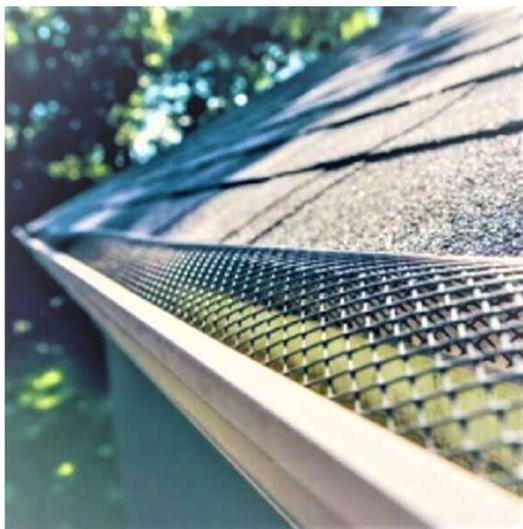
Figura 10: Tela para calha anti folha, marca Tegape Telas ou similar.
