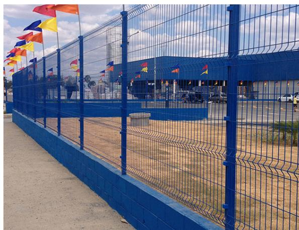
Figura 22: Gradil metálico sobre mureta, modelo Gradil Morlan ou similar.
