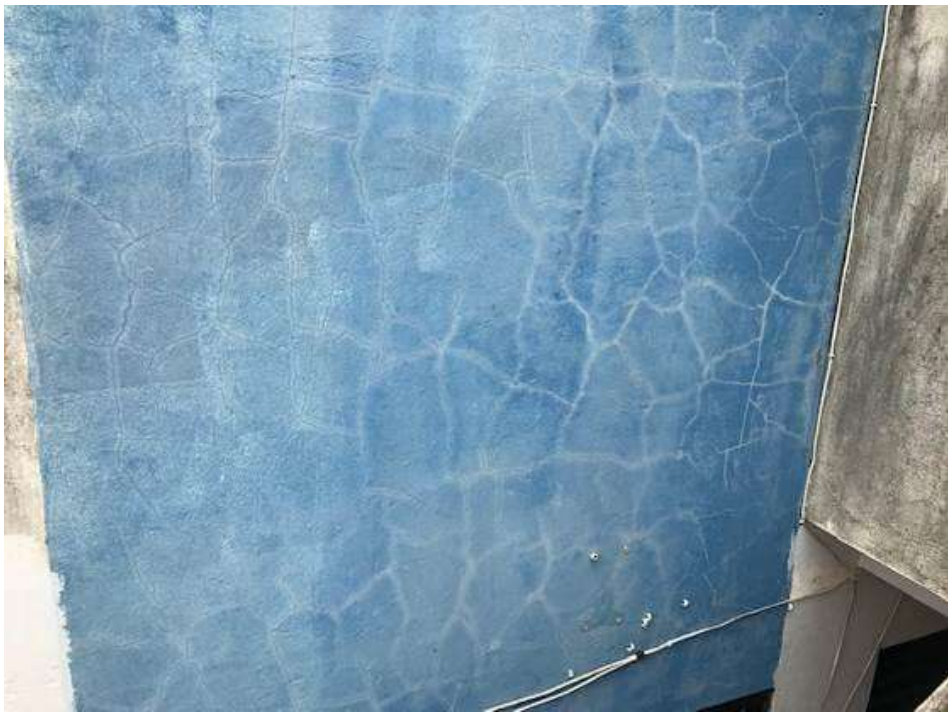
Figura 31 – Mapeamento no revestimento da fachada por pintura com prazo de validade superado.
