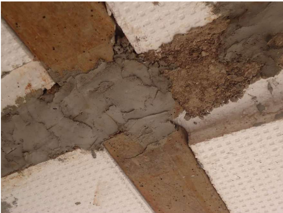
Figura 161 – Lajes com falhas na produção.
