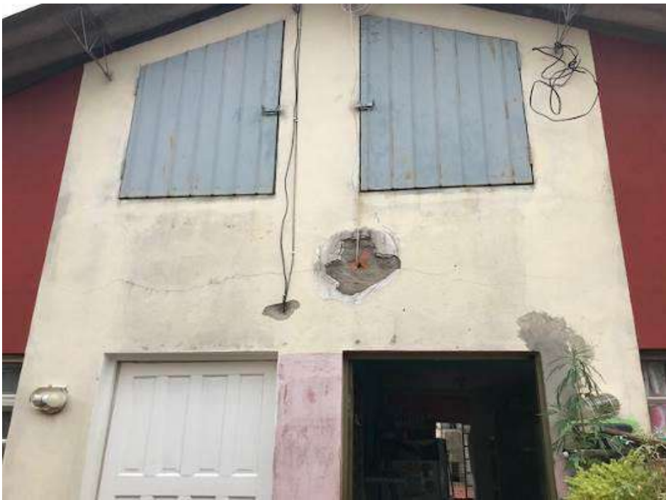
Figura 27 – Danos ocorridos no revestimento por quebras para passagem de fiação.
