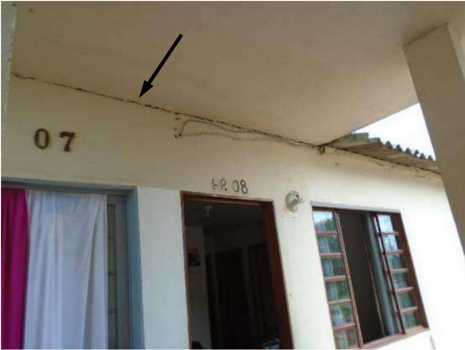
Figura 97 – Fissura na interface entre laje e parede.
