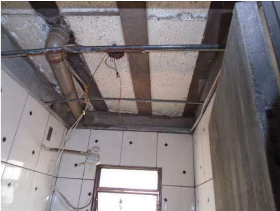
Figura 136 – Incêndio causou danos no teto e tubulações do banheiro.
