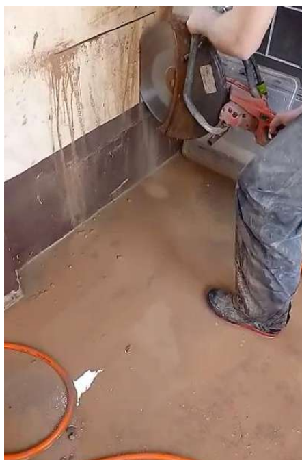
Figura 1 – Corte das paredes para retirar as amostras.
