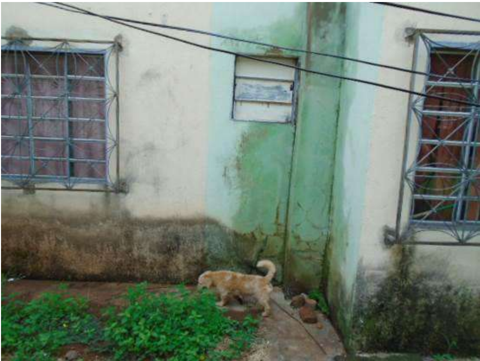
Figura 126 – Existe infiltração na região do shaft.
