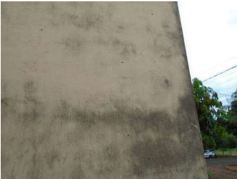
Figura 25 – Revestimento sem manutenção na fachada.
