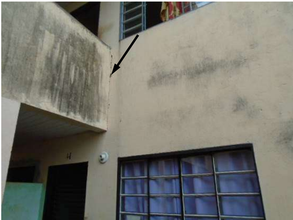
Figura 99 – Fissura na interface entre parede e escadaria.
