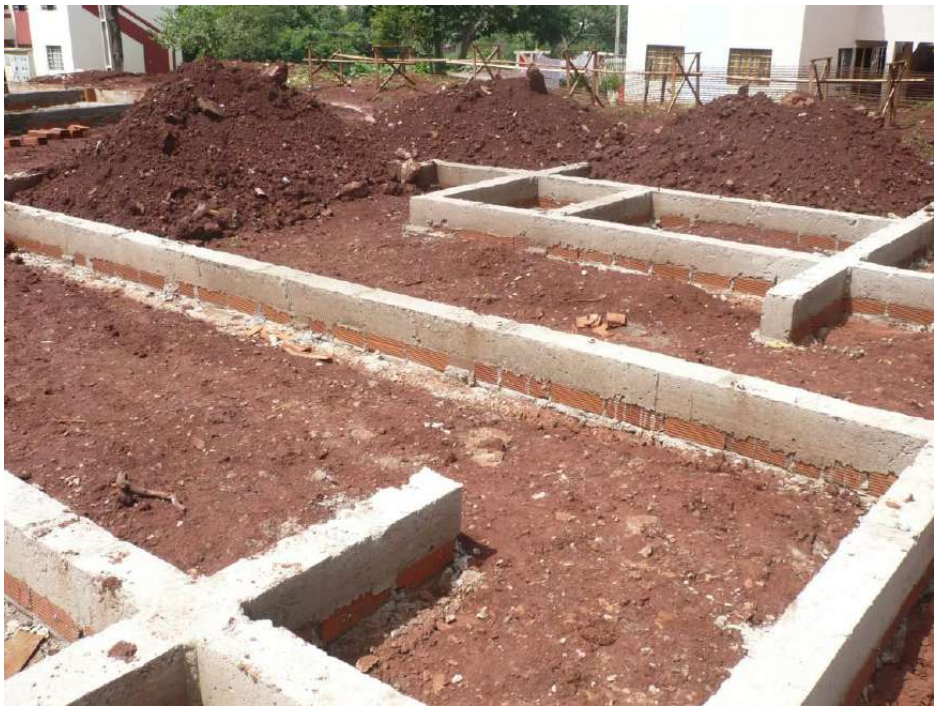
Figura 145 – Viga de fundação concretada.
