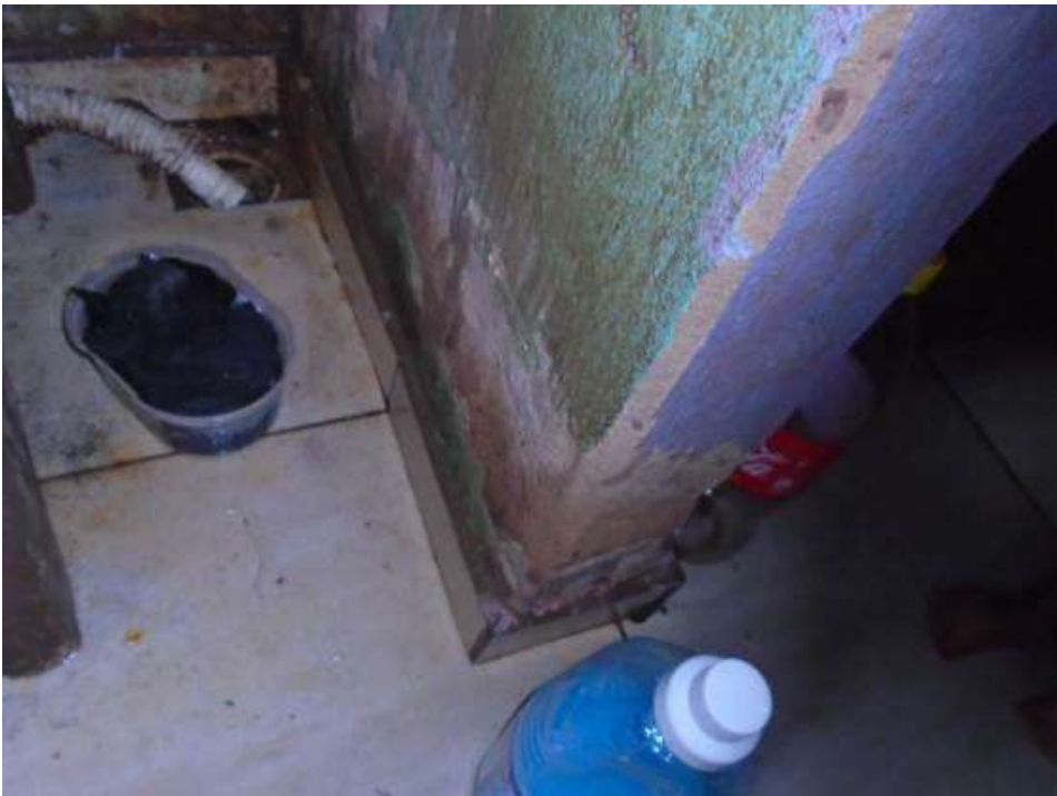
Figura 54 – Revestimento danificado pela umidade ascendente.
