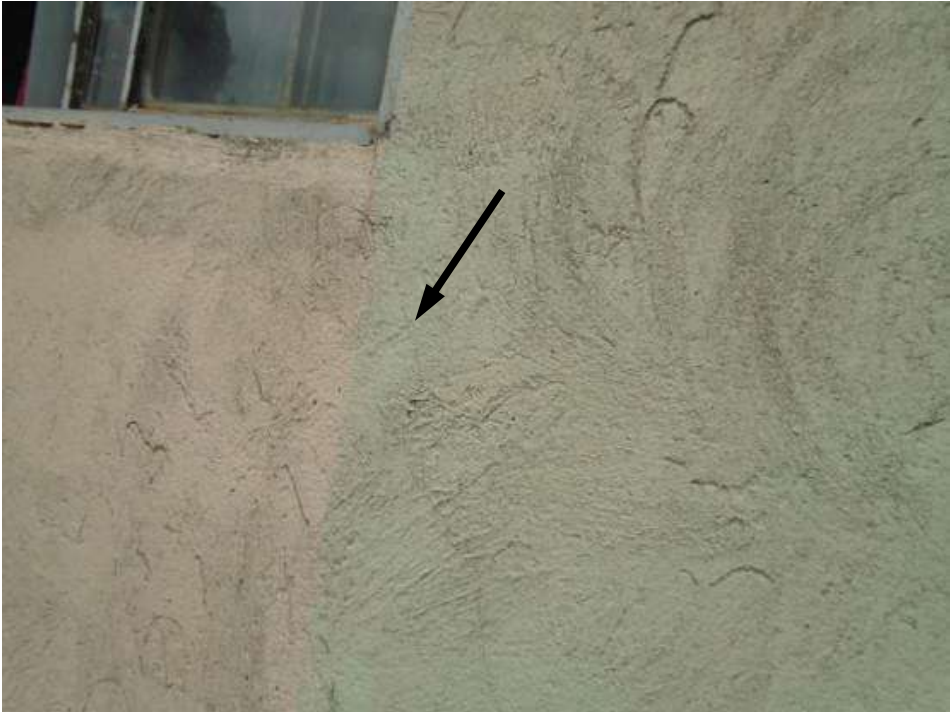
Figura 86 – Fissura no canto da janela.
