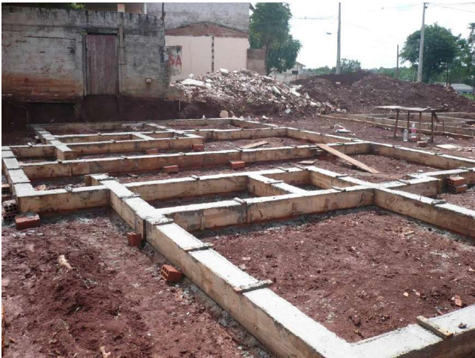
Figura 8 – Viga de fundação concretada.
