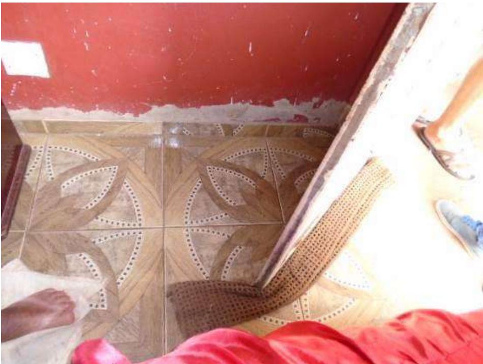
Figura 37 – Umidade ascendente na parede no pavimento térreo.
