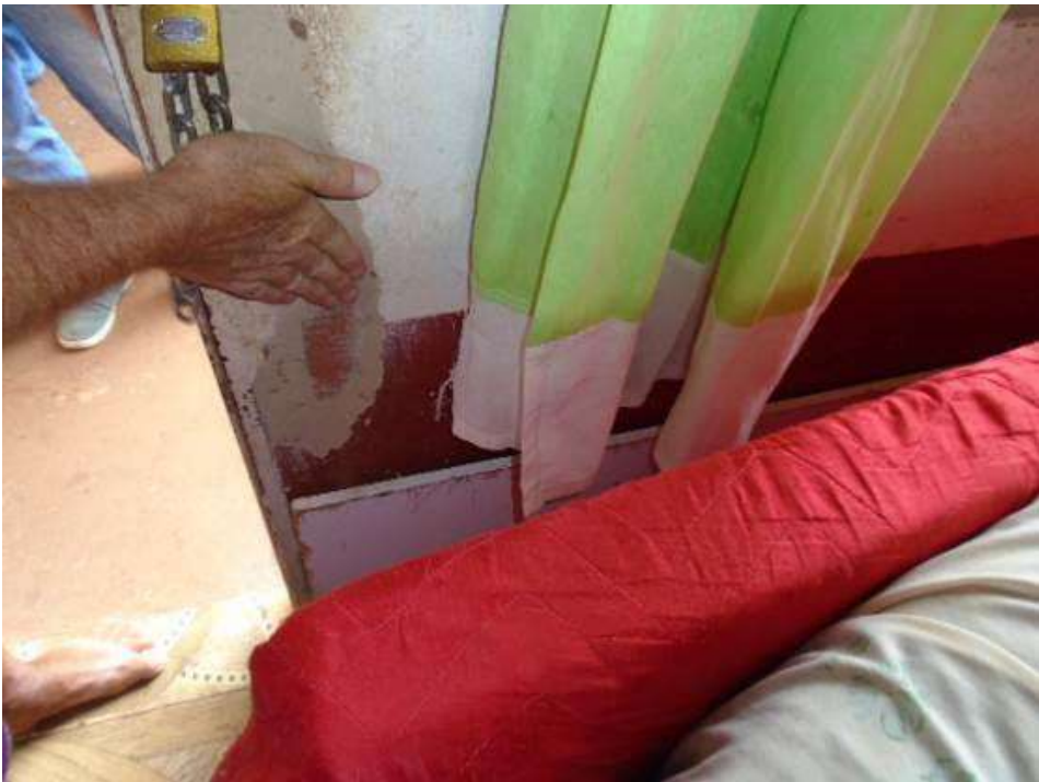
Figura 38 – Baixa resistência do revestimento da argamassa.
