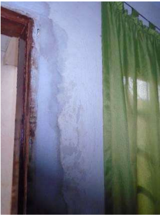
Figura 115 – Quebras realizadas pelo morador por alteração da porta.
