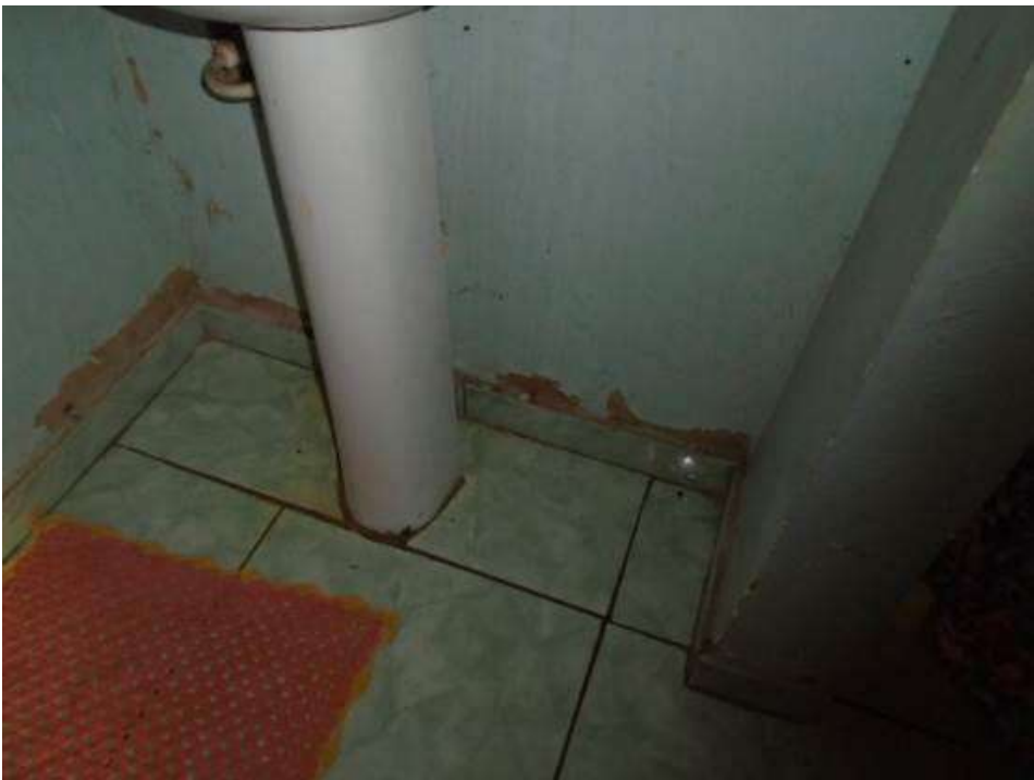
Figura 55 – Umidade junto ao piso danificando o revestimento.
