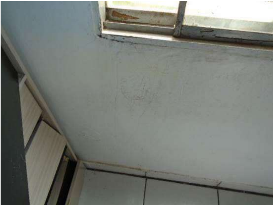
Figura 80 – Janela danificada onde penetra umidade.
