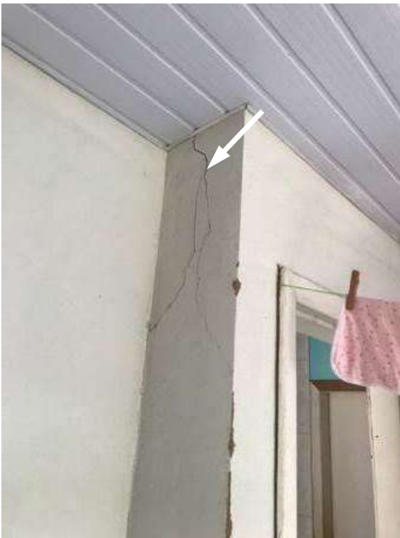
Figura 73 – Fissura vertical no canto de uma das paredes do segundo pavimento.
