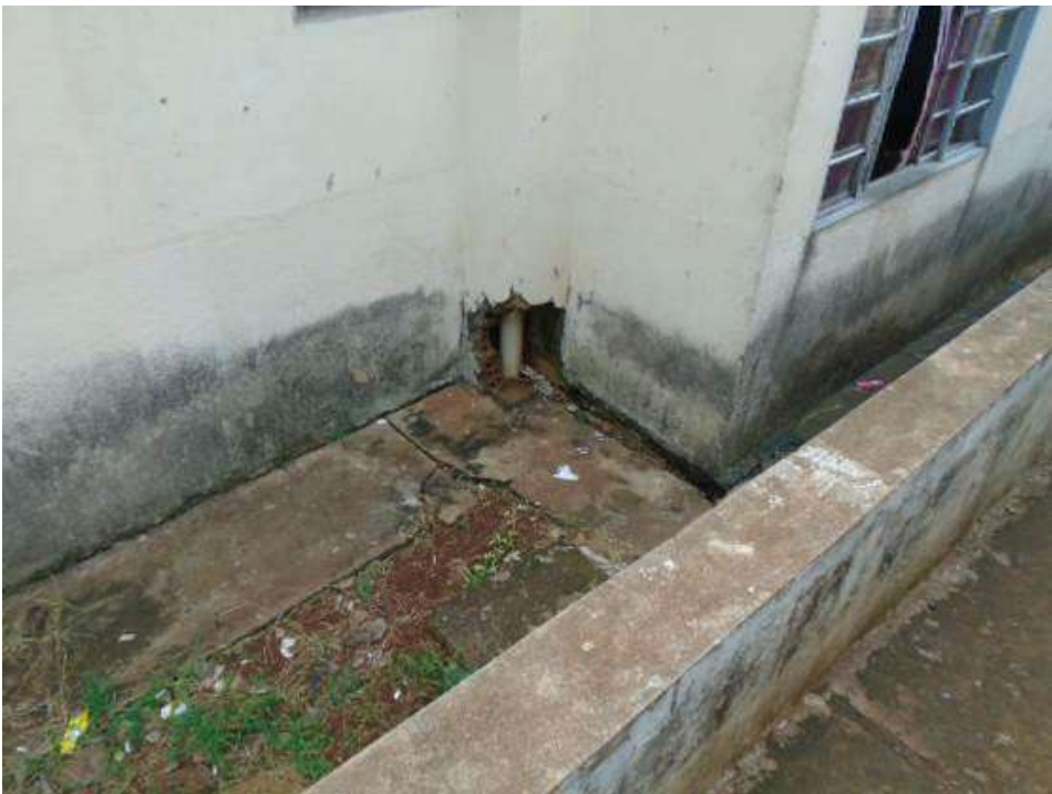
Figura 125 – Local onde houve vazamento de tubulações e quebras para correção do local.
