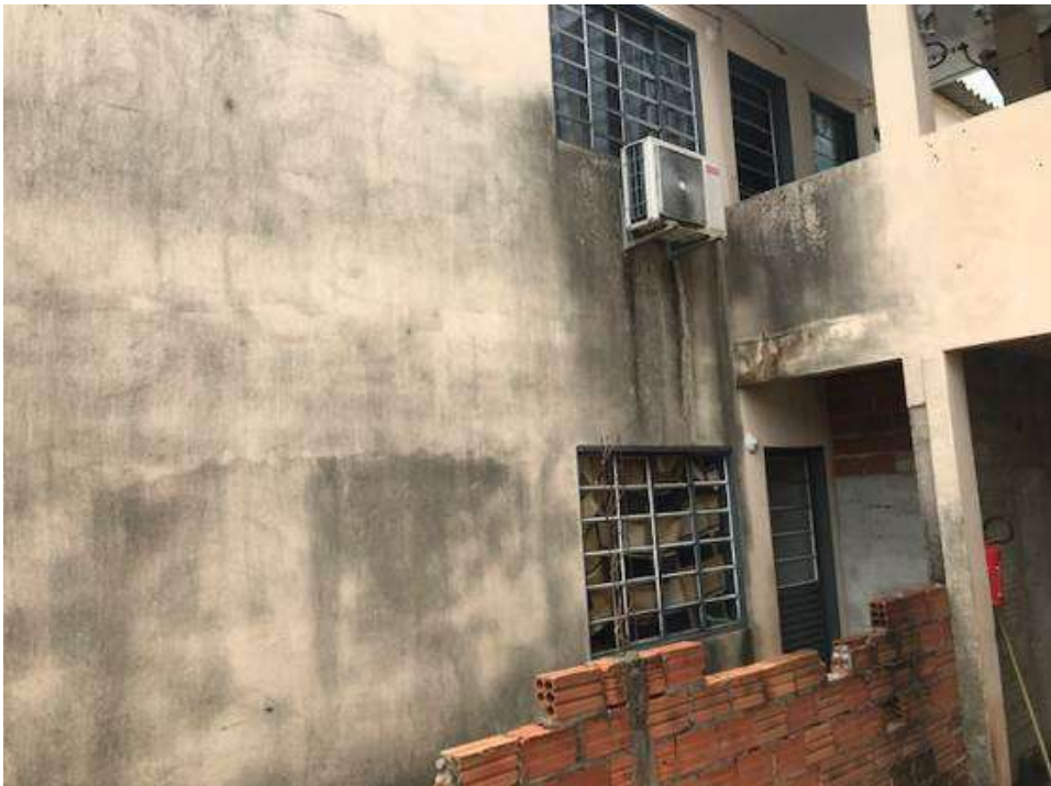
Figura 34 – Fungos presentes na fachada, devendo realizar a limpeza e pinturas periódicas.
