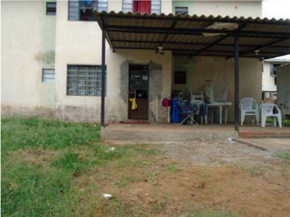
Figura 130 – Alteração da porta para parte dos fundos da unidade e criação de cobertura.
