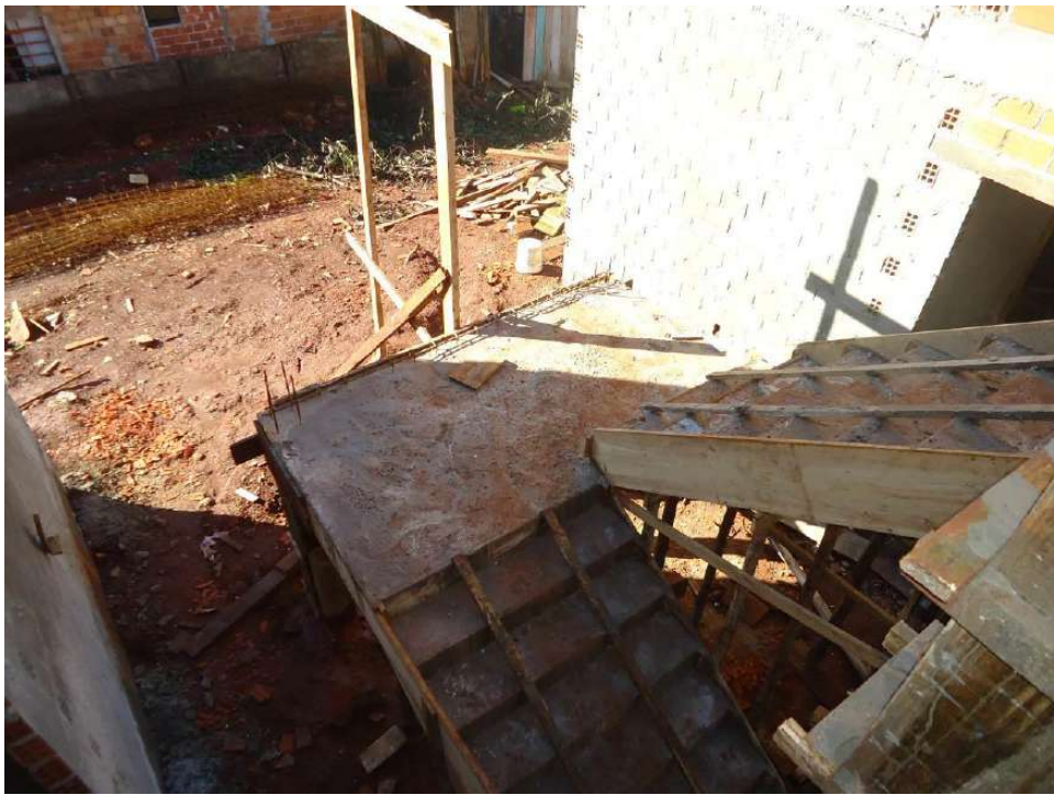
Figura 159 – Escadaria de concreto armado.
