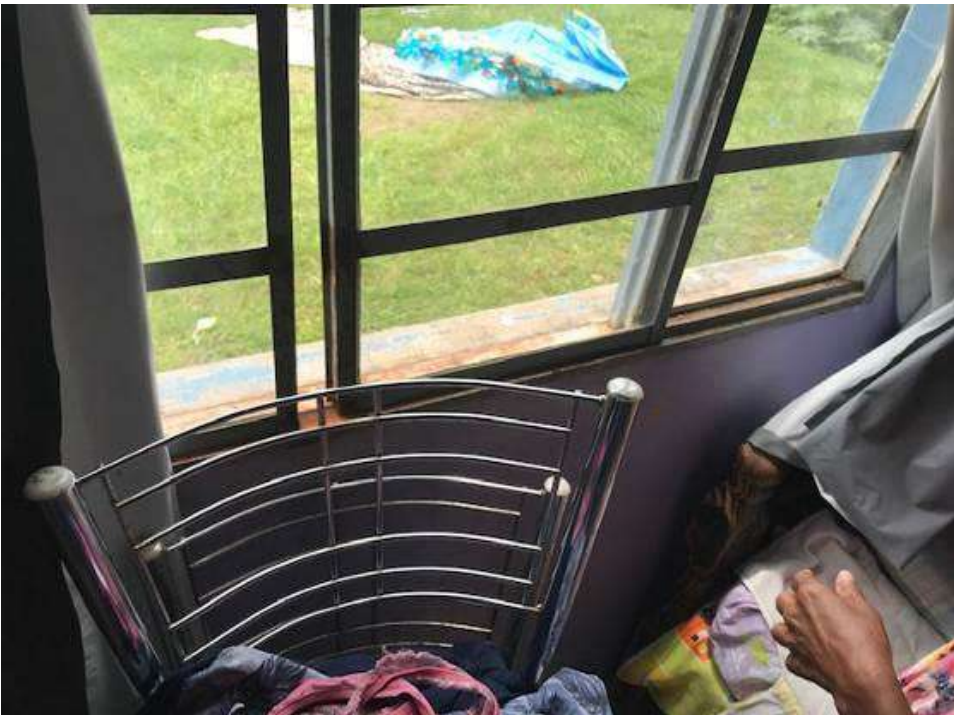
Figura 88 – Janelas com dificuldade de fechamento por baixa rigidez.
