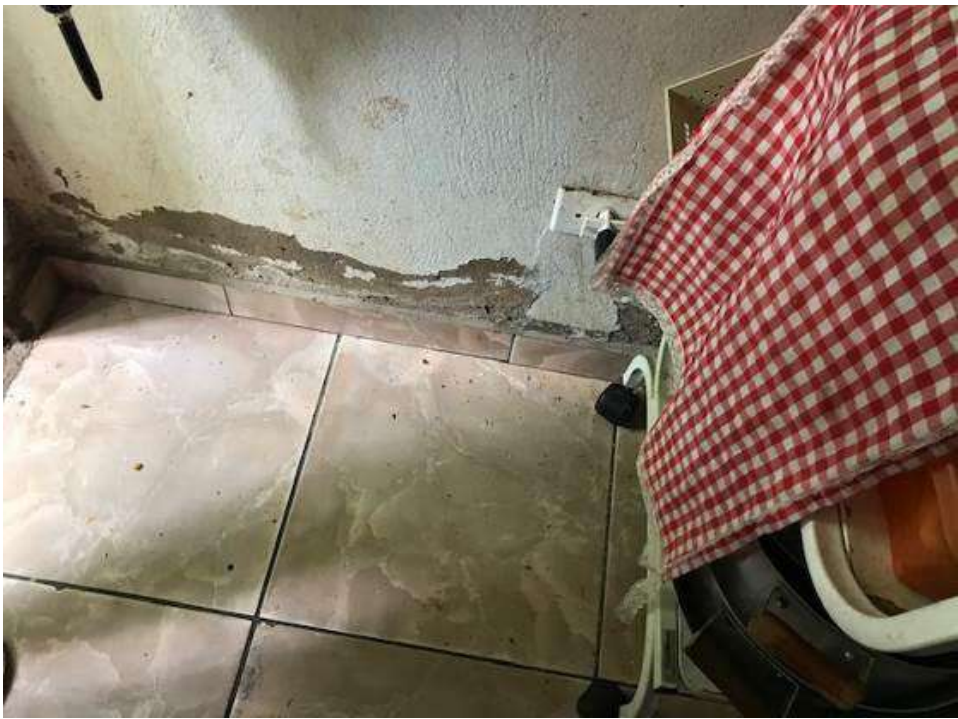
Figura 61 – Revestimento interno danificado por umidade nas paredes.
