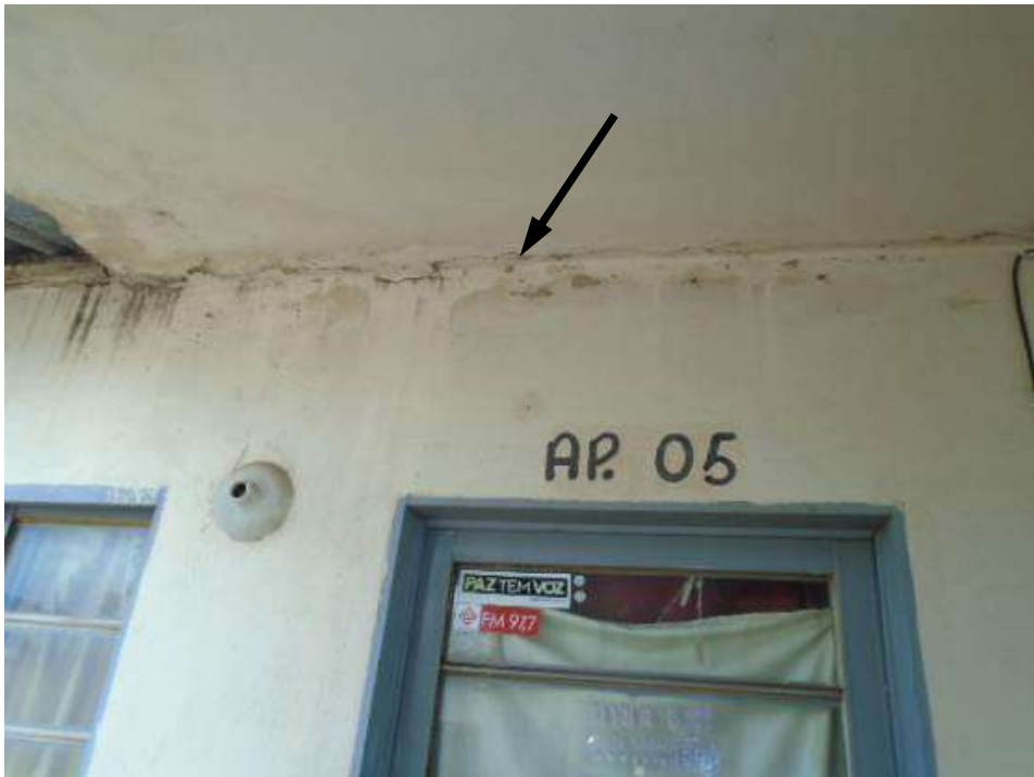
Figura 100 – Fissura na interface entre laje e parede do segundo pavimento.
