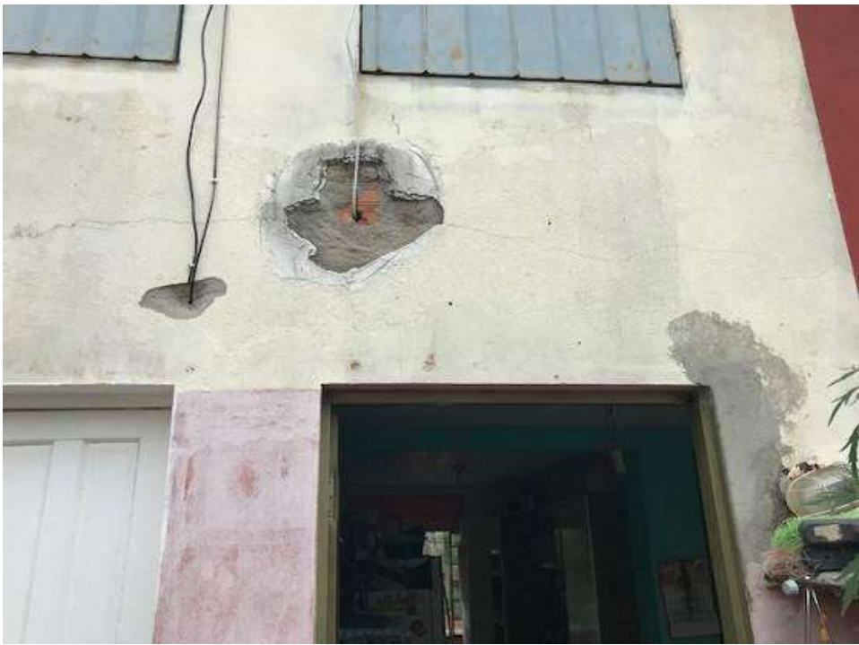
Figura 29 – Danos na fachada decorrentes de instalação de fiação.
