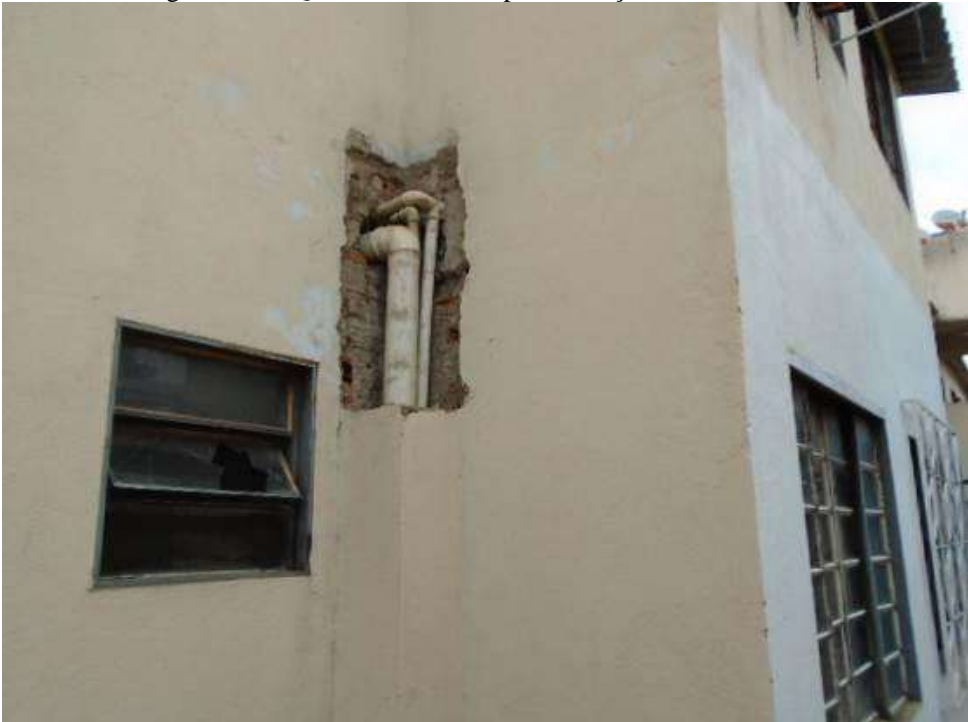
Figura 124 – Local onde houve vazamento de tubulações e quebras para correção do local.
