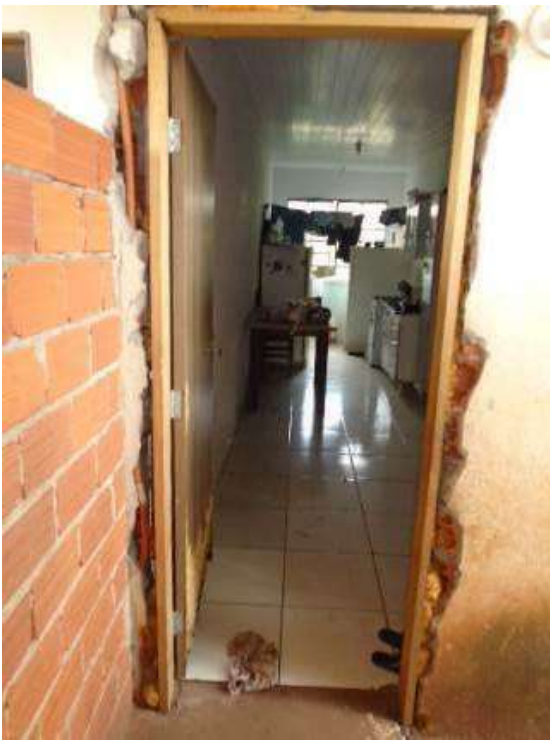
Figura 119 – Danos significativos na alvenaria para instalação de portas.
