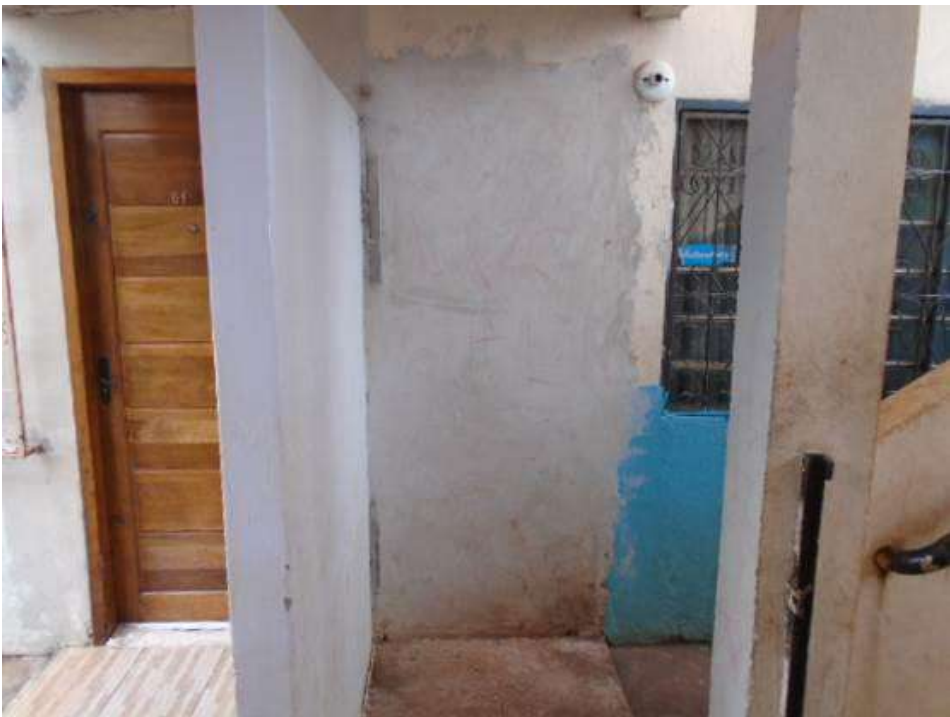
Figura 129 – Fechamento de porta na posição original e criação de parede que divide unidades na parte externa.
