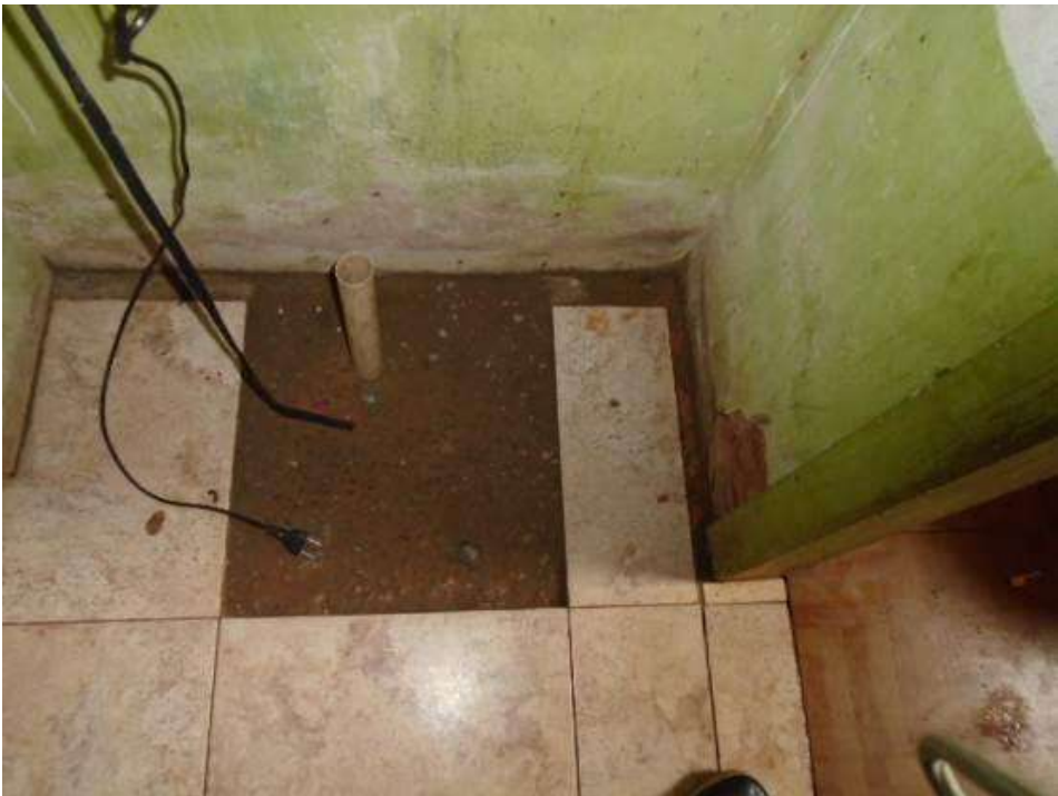
Figura 50 – Piso com umidade significativa ascendente.
