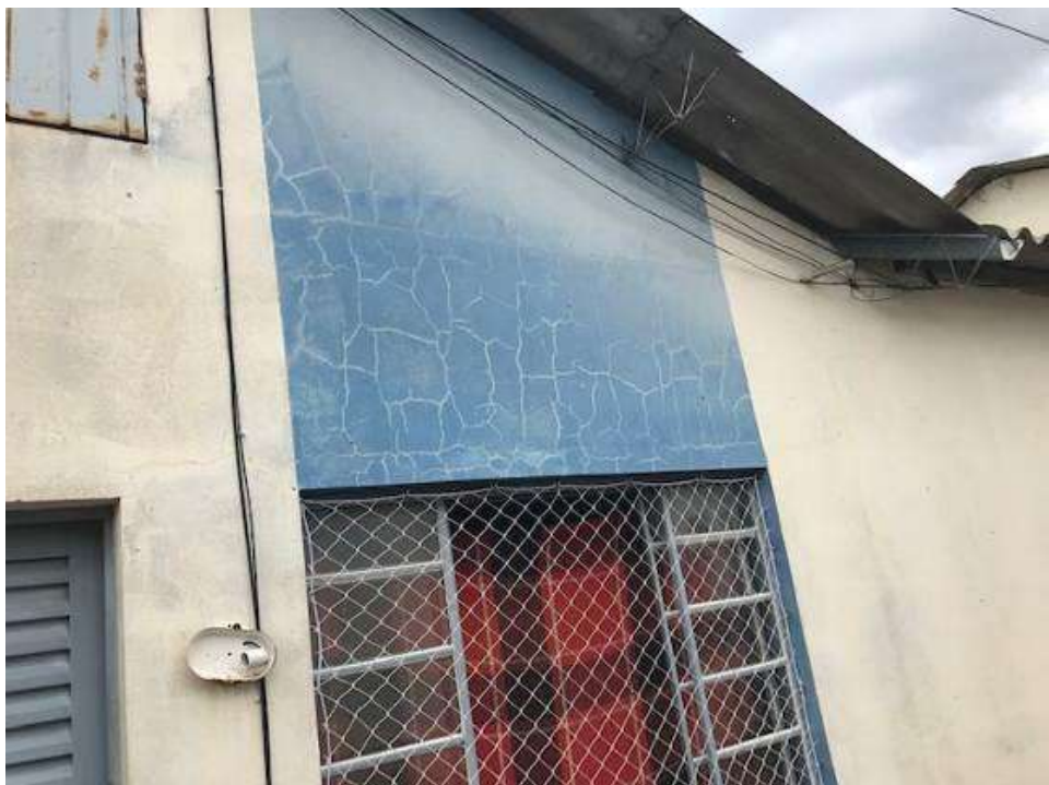
Figura 19 – Fissuras de mapeamento na fachada, mas patologia restrita ao revestimento..
