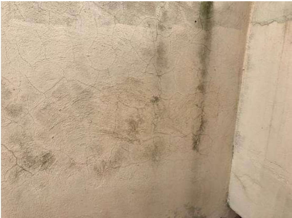
Figura 36 – Fissura de mapeamento na fachada.
