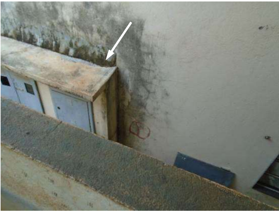
Figura 137 – Presença de umidade junto ao quadro de luz na fachada do prédio.
