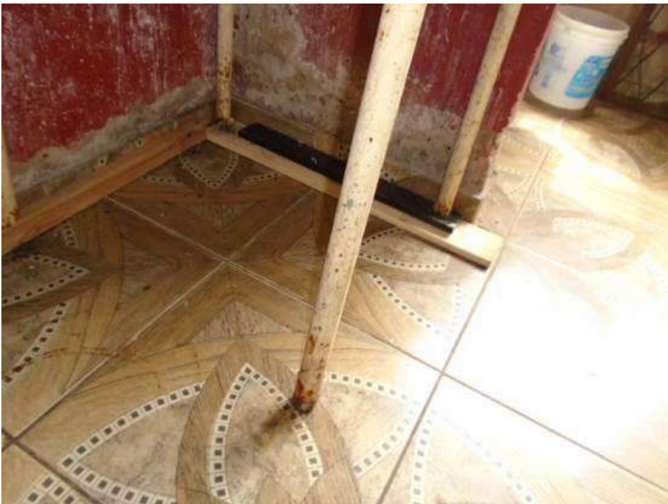
Figura 43 – Umidade ascendente na região da cozinha.
