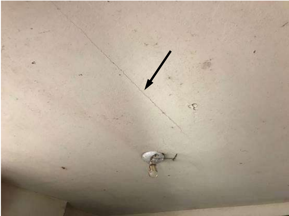
Figura 108 – Fissura significativa na sala.
