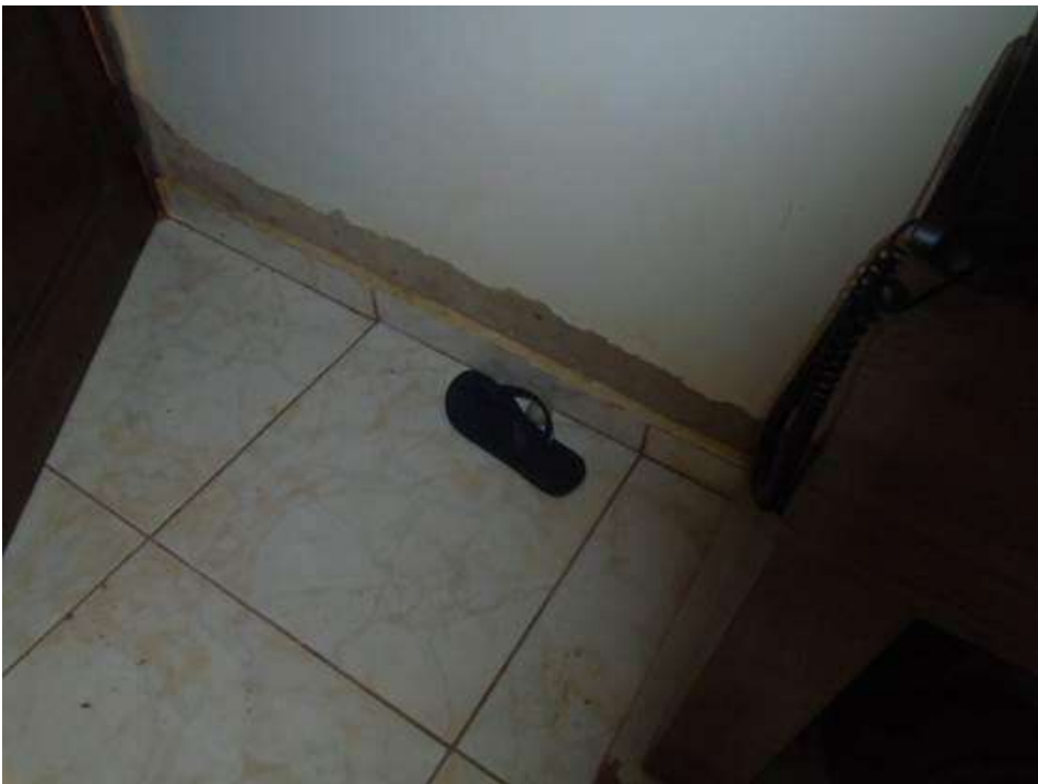
Figura 57 – Umidade ascendente proveniente das fundações.
