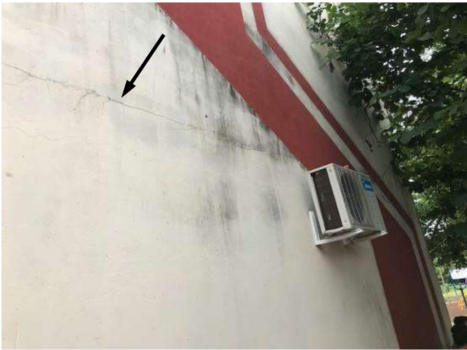
Figura 75 – Fissura horizontal no nível da laje.
