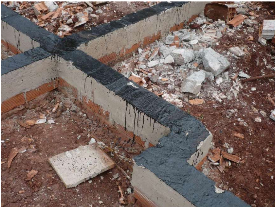
Figura 10 – Vista de fundação executada em concreto armado, sem blocos canaletas.
