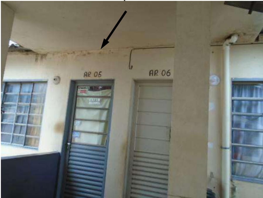
Figura 96 – Fissura é infiltração no segundo pavimento.
