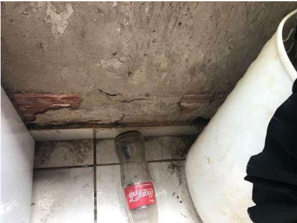
Figura 58 – Umidade degradando a estrutura das paredes.
