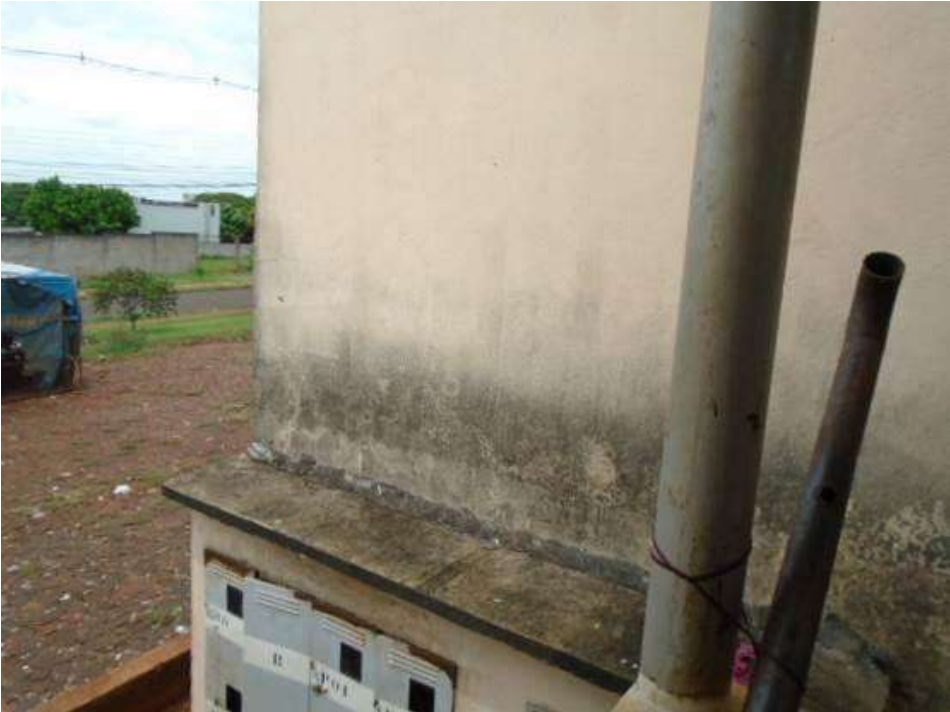
Figura 138 – Umidade junto ao quadro de luz na fachada do prédio
