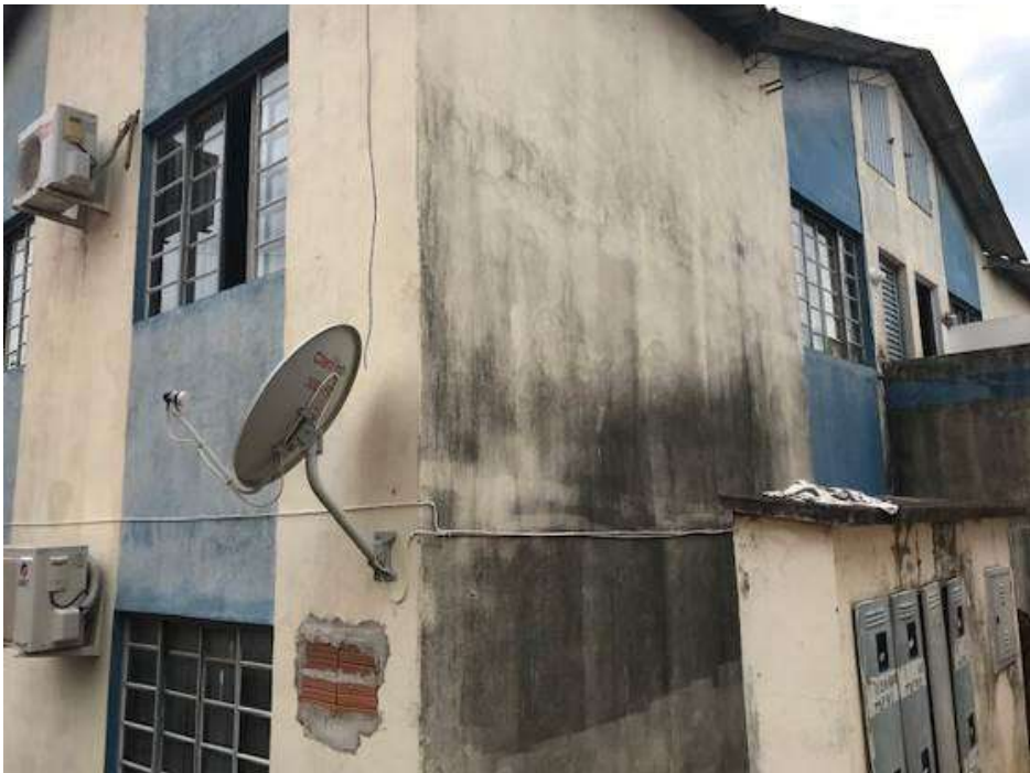
Figura 28 – Escurecimento da fachada e danos na alvenaria no canto da parede, onde foi instalado equipamento de ar condicionado.
