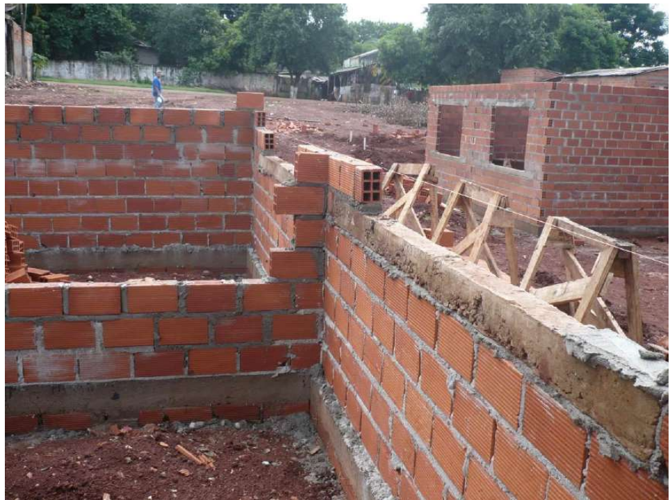
Figura 152 – Contraverga da janela com peça pré-moldada.
