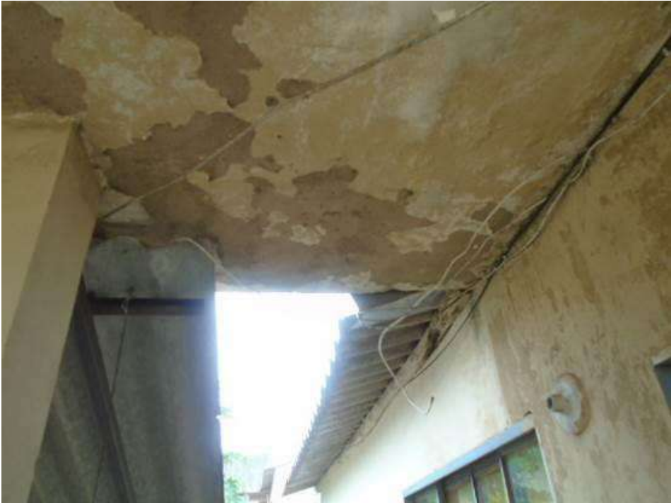
Figura 102 – Laje na região da escadaria com infiltrações.
