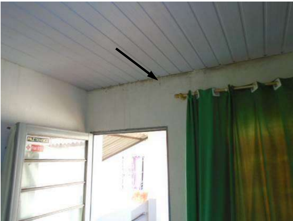
Figura 101 – Infiltração interna no apartamento causado por falhas na vedação da laje de cobertura da escadaria.
