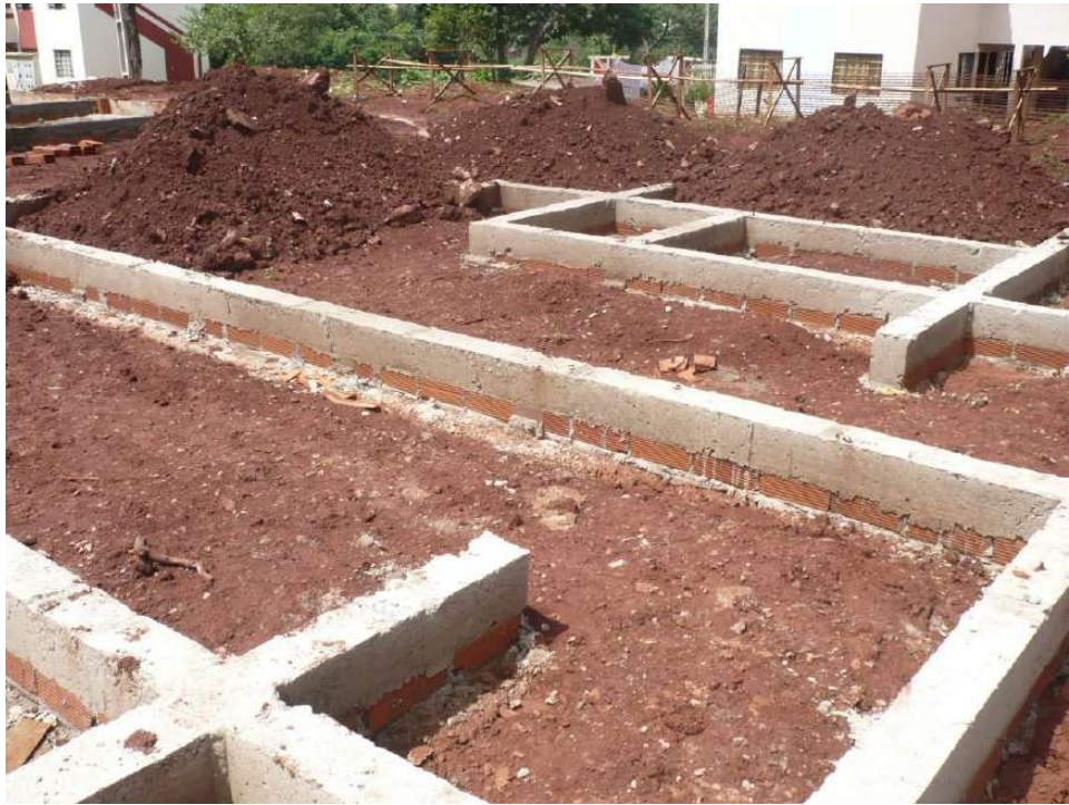
Figura 9 – Viga de fundação concretada com largura e altura superior ao previsto em projeto.
