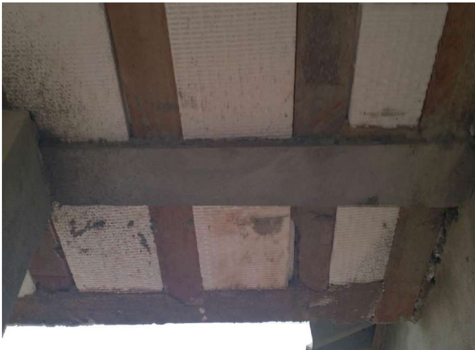
Figura 165 – Reforço executado na região da laje durante a execução da obra.
