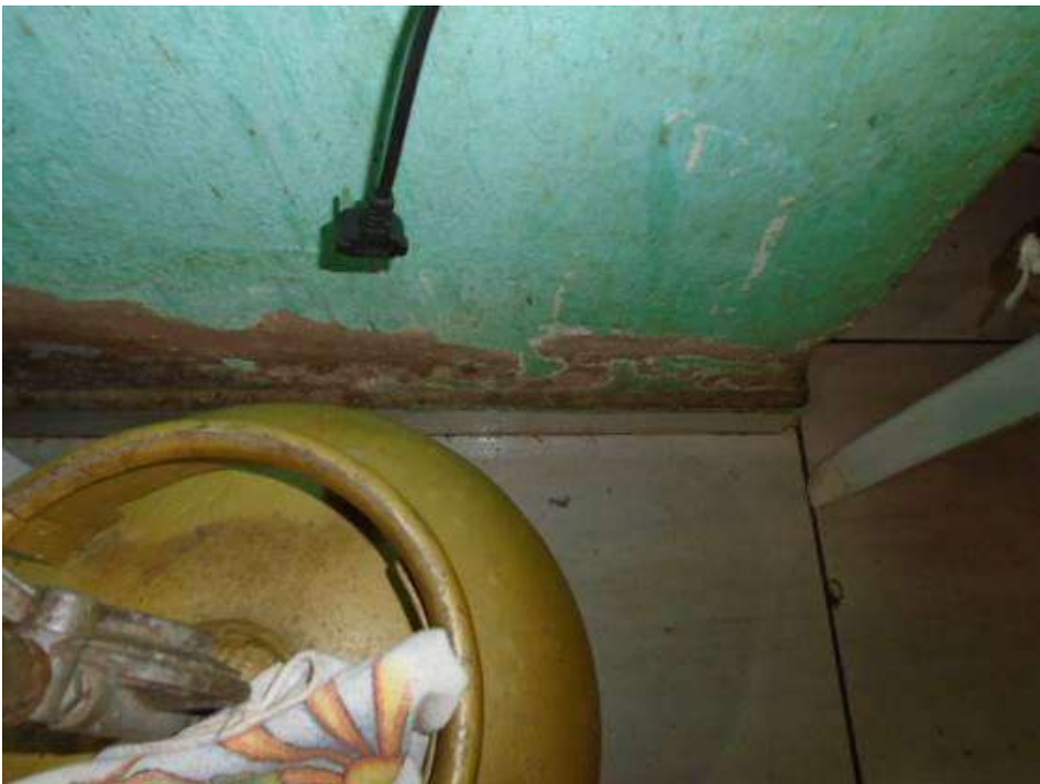
Figura 51 – Umidade ascendente causando baixa resistência no revestimento.
