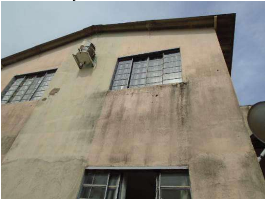
Figura 22 – Fachada sem manutenção da pintura, mas sem fissuras estruturais visíveis.
