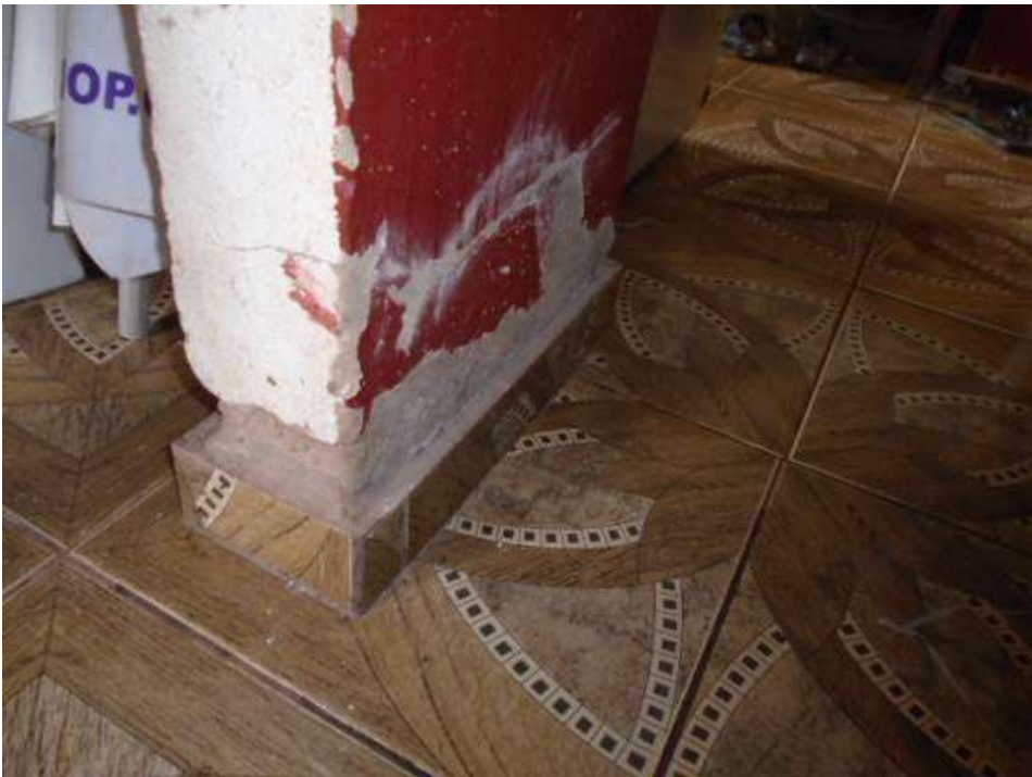
Figura 40 – Baixa resistência do revestimento interno da unidade.
