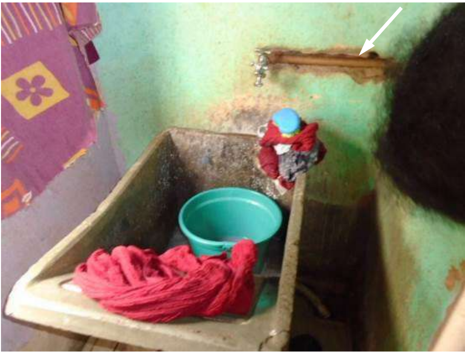
Figura 133 – Quebras nas paredes para passagem de tubulações.
