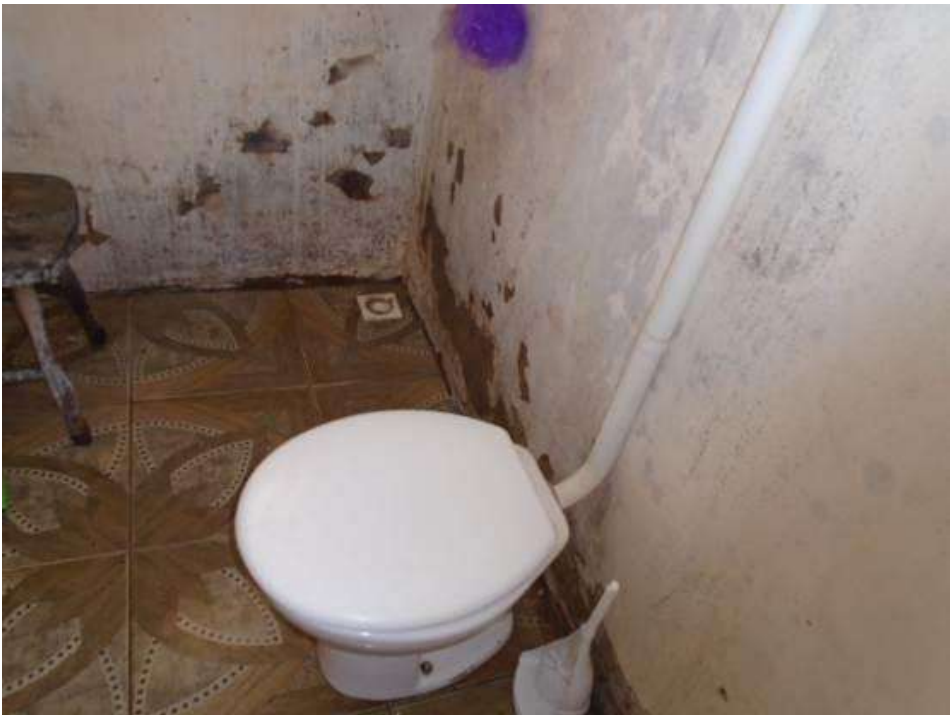
Figura 42 – Baixa resistência do revestimento na região do banheiro.
