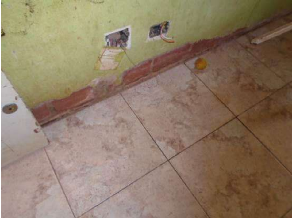
Figura 46 – Outro apartamento com umidade ascendente.
