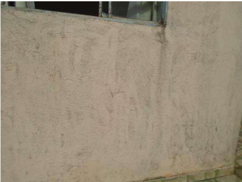
Figura 79 – Janela instalada sem fissura ao seu redor.
