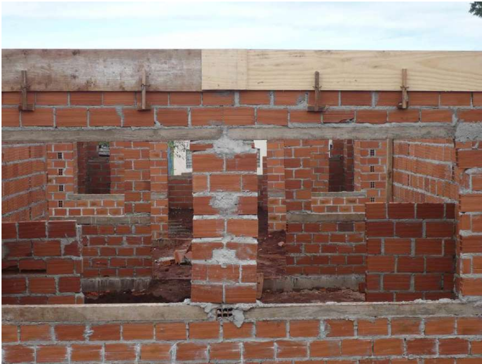
Figura 156 – Pré-moldados de vergas e contravergas das janelas.
