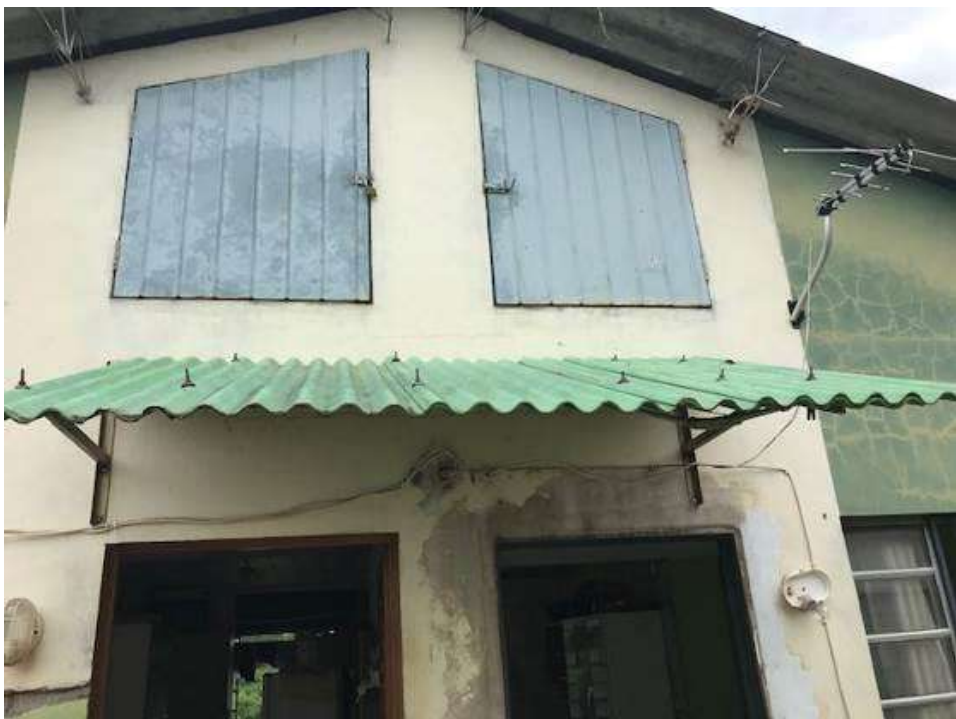
Figura 33 – Instalação de cobertura sobre as portas para reduzir impactos da umidade.
