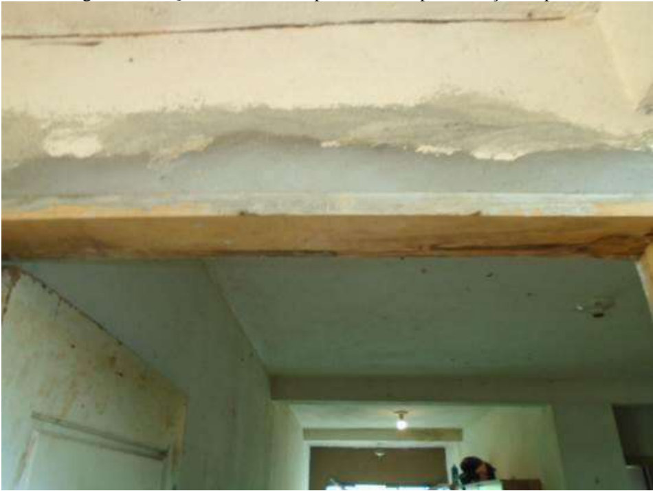
Figura 116 – Aumento da dimensão da porta removendo verga da estrutura.
