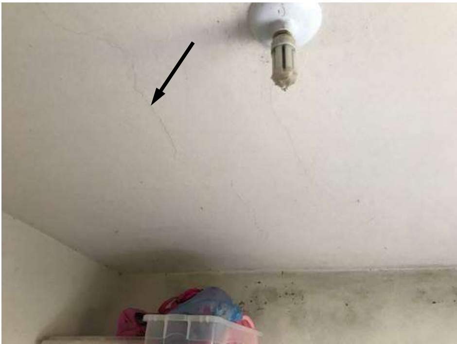
Figura 107 – Fissuras no teto da laje do quarto.
