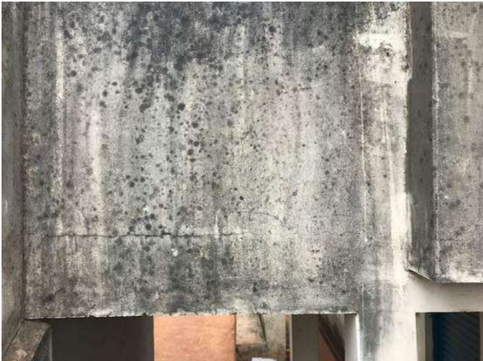
Figura 32 – Não foram executadas manutenções periódicas da pintura na fachada, favorecendo proliferação de mofo.
