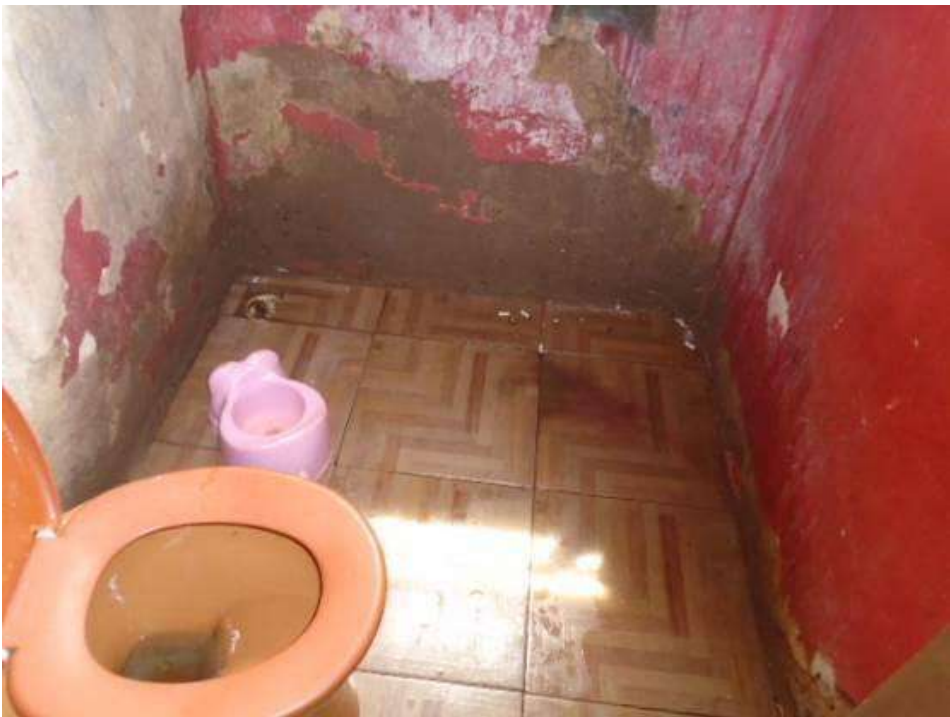
Figura 49 – Revestimento interno com baixíssima resistência na região do box do banheiro.
