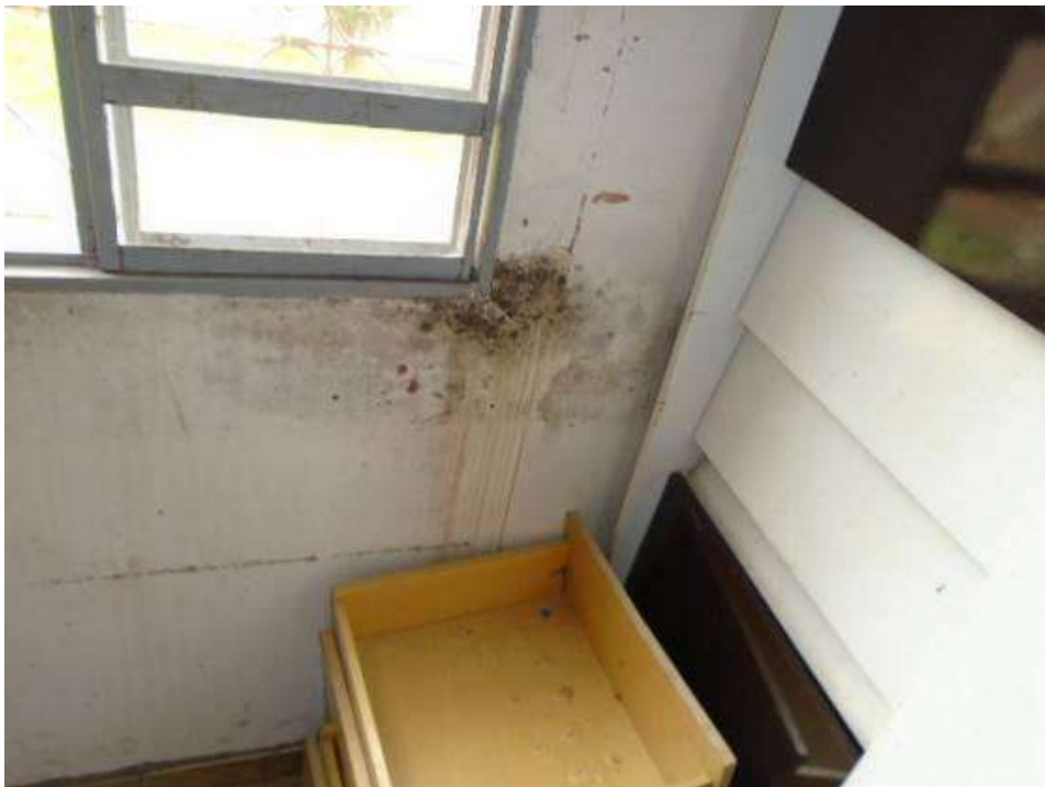
Figura 83 – Detalhe de umidade no canto da janela.
