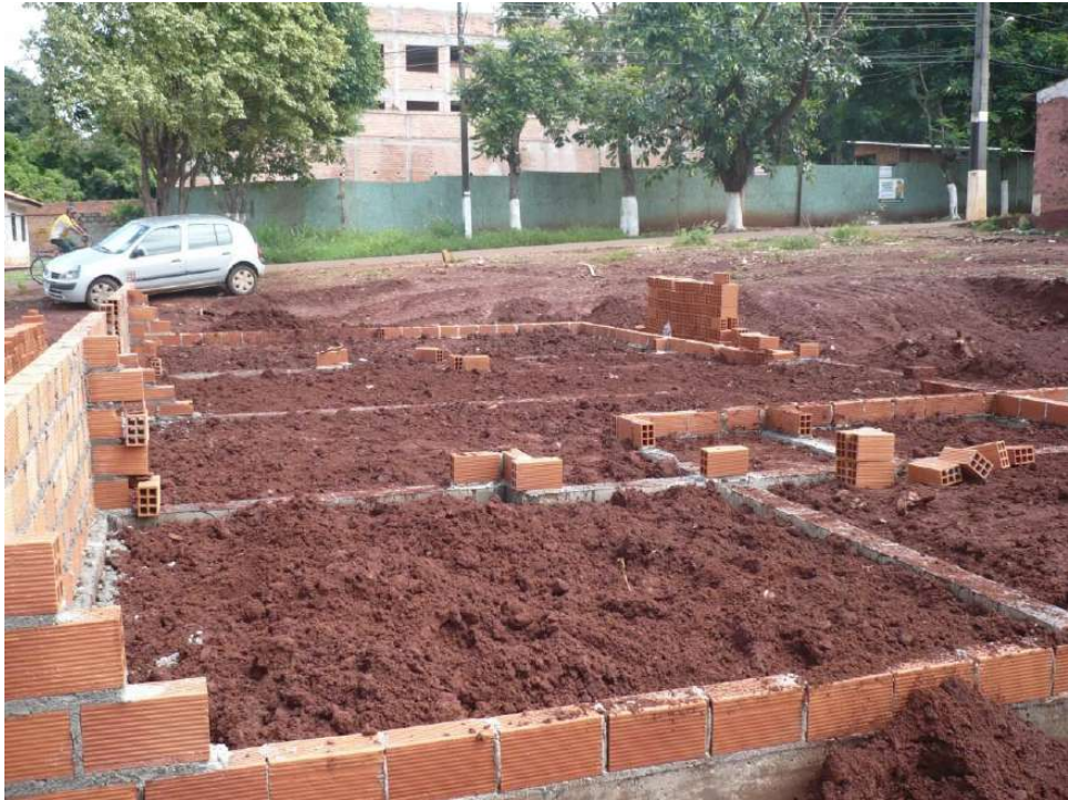
Figura 150 – Falta de impermeabilização da viga com alvenaria em execução.
