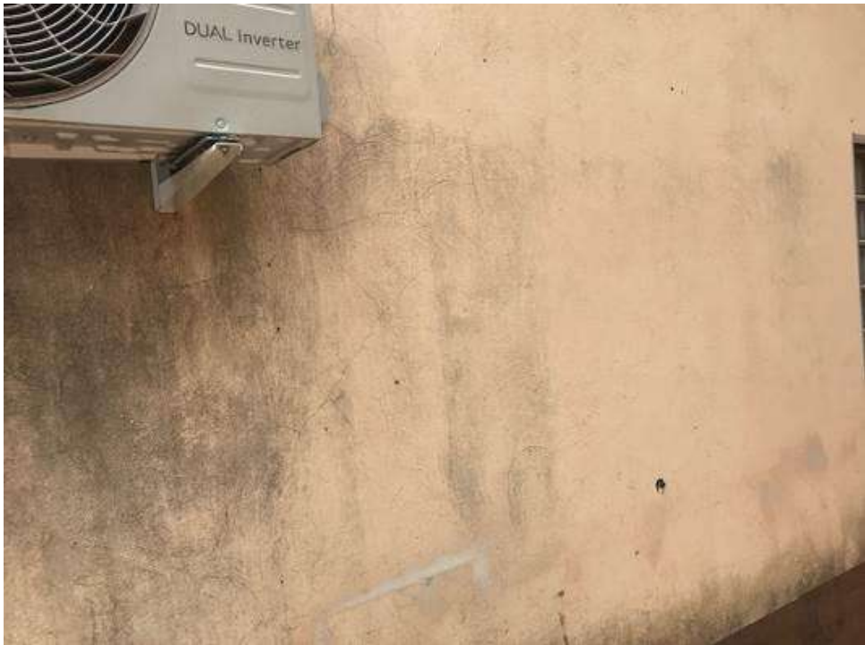
Figura 20 – Escurecimento da fachada com fissuras de mapeamento.
