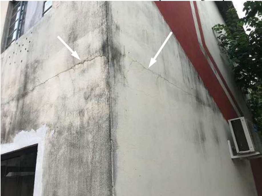
Figura 74 – Fissura horizontal no nível da laje.
