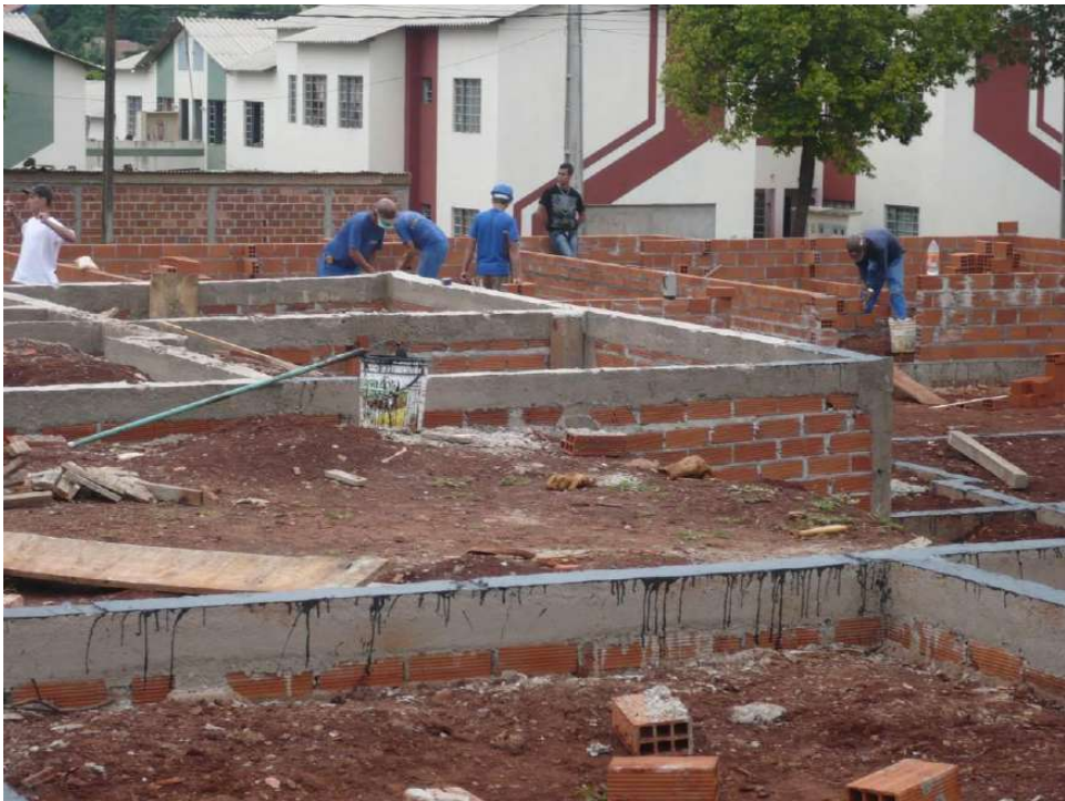
Figura 148 – Execução das vigas de fundação.
