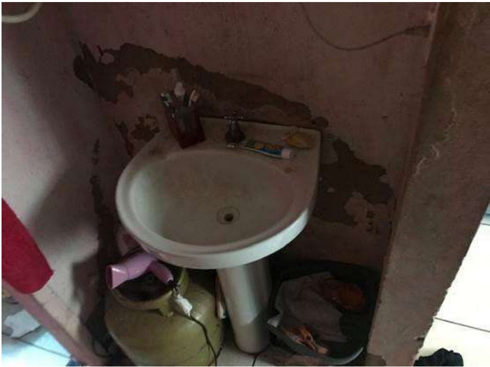
Figura 60 – Umidade na parede e revestimento com baixa resistência.
