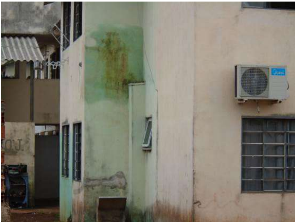
Figura 121 – Shaft próximo ao banheiro para passagem de tubulações.
