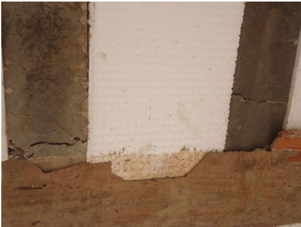
Figura 163 – Fissuras nas vigas das lajes.
