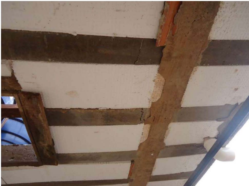
Figura 164 – Laje deformada na região da escadaria, onde são localizados os reservatórios.
