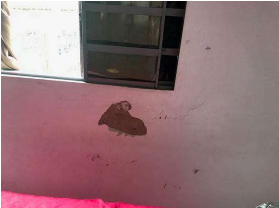
Figura 90 – Janela com infiltração no peitoril.
