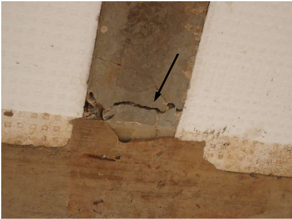
Figura 162 – Fissuras nas vigas das lajes entrepisos.
