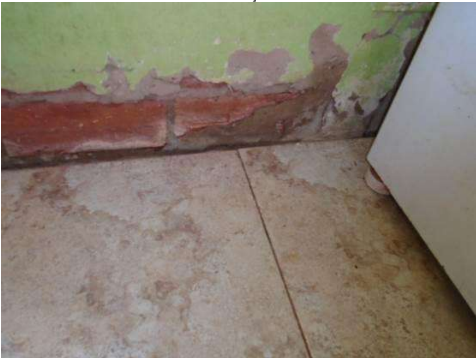
Figura 48 – Baixa resistência do revestimento, aliado a infiltração de umidade ascendente.
