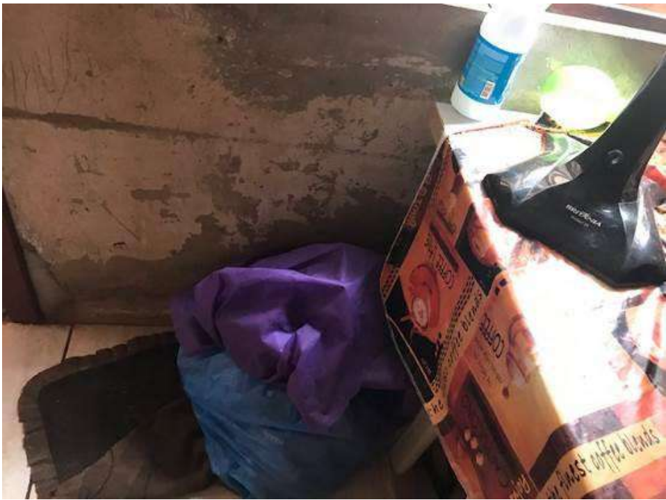
Figura 59 – Revestimento interno com baixa resistência.
