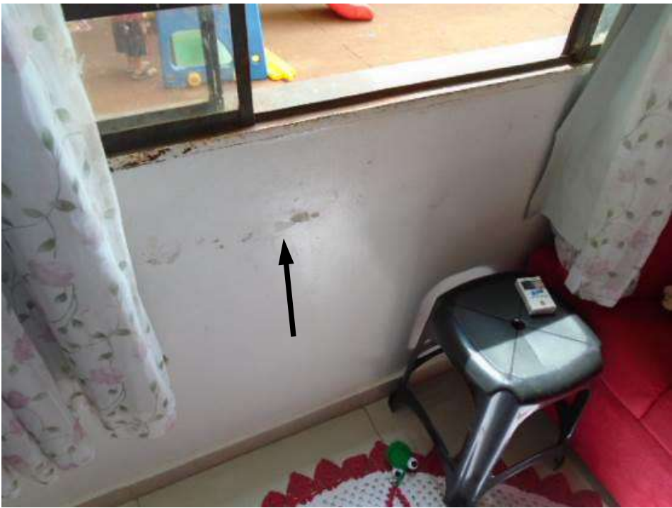
Figura 85 – Umidade abaixo do peitoril da janela.
