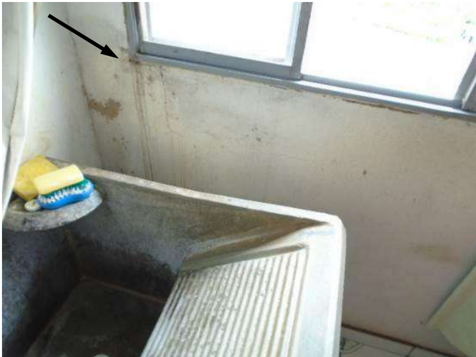
Figura 84 – Umidade próximo ao canto da janela.
