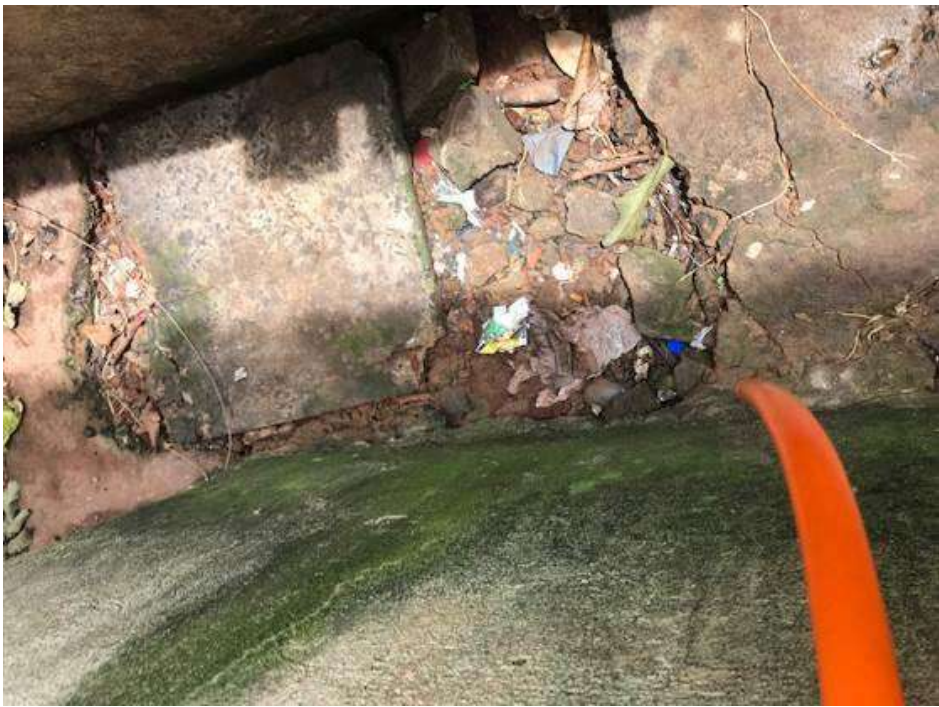
Figura 65 – Parte externa da habitação com calçadas danificadas e sem escoamento de água nesta região, o que favorece a ocorrência de umidade ascendente.
