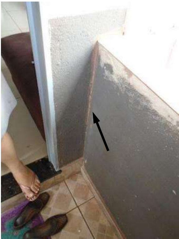
Figura 95 – Fissura entre parede da escadaria e do apartamento com vedação da interface entre componentes.
