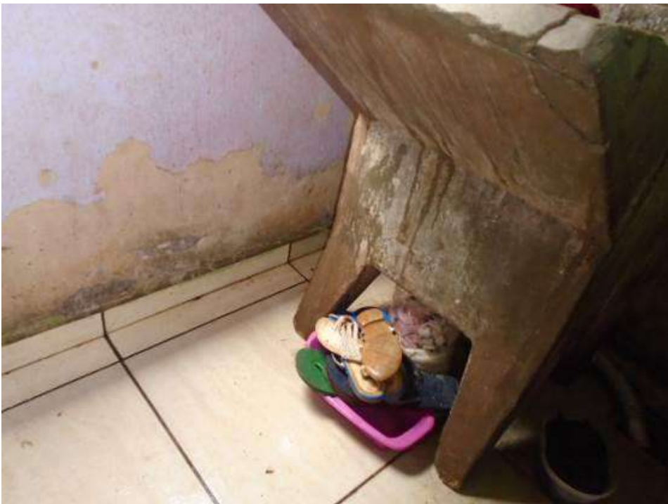
Figura 53 – Área de serviço com baixa resistência do revestimento e umidade ascendente.
