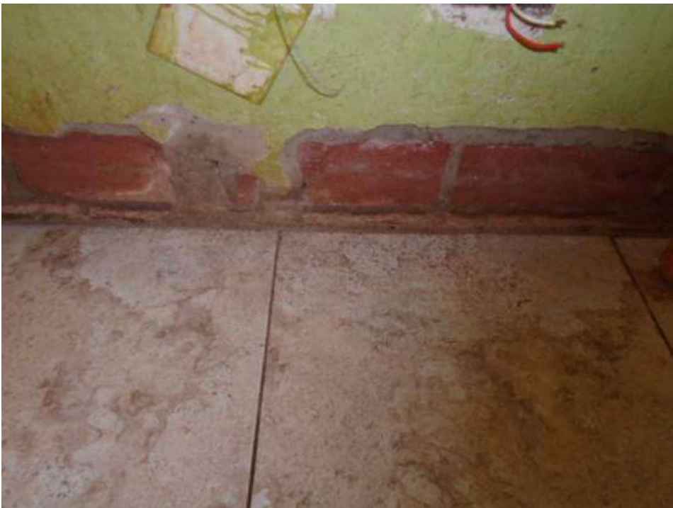
Figura 47 – Baixa resistência do revestimento próximo ao piso, decorrente de umidade proveniente da fundação.
