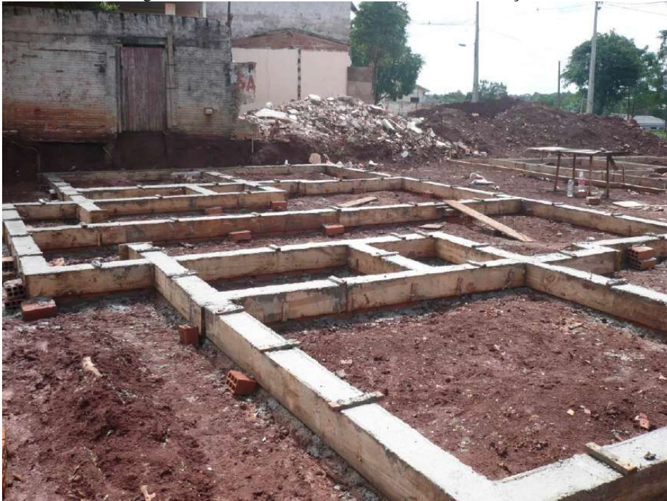
Figura 144 – Viga de fundação concretada.
