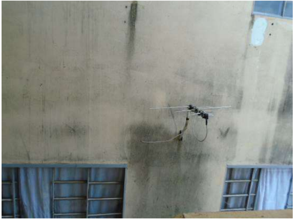
Figura 26 – Pontos com fixação de elementos na fachada, o que favorece a infiltração para o interior da unidade.
