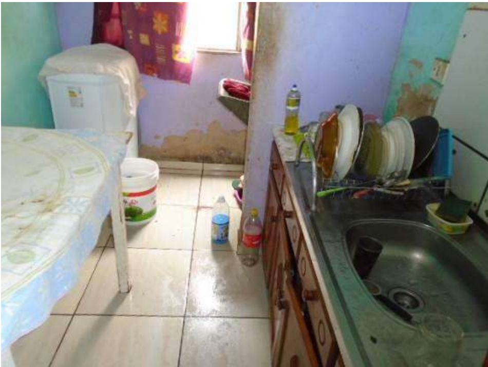
Figura 52 – Cozinha com baixa resistência do revestimento.
