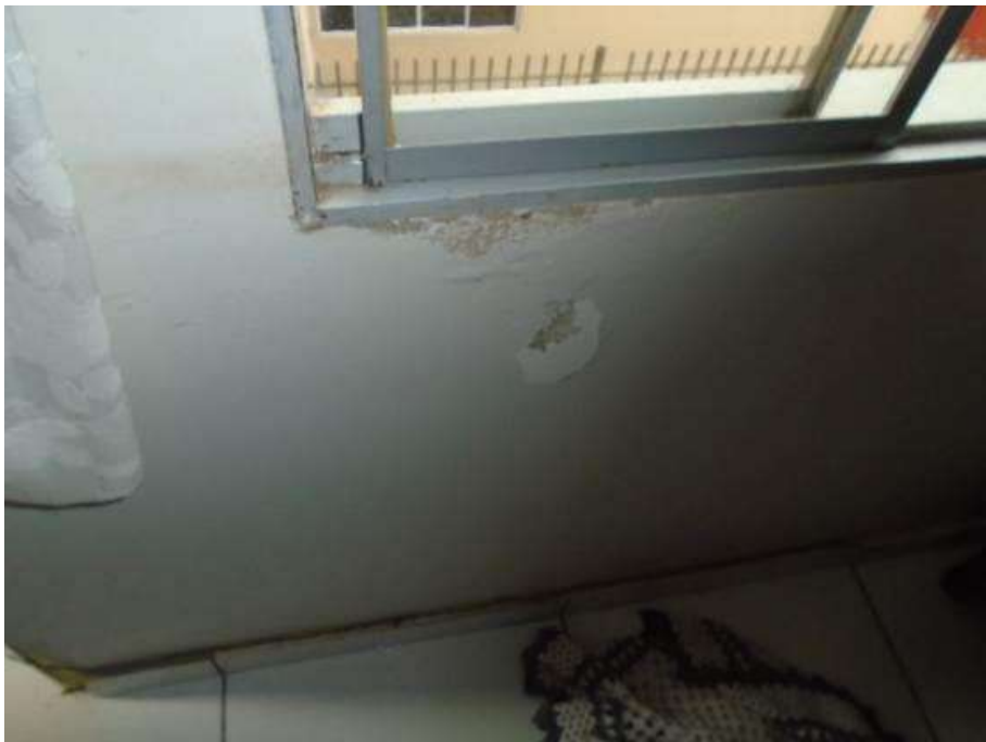
Figura 81 – Infiltração abaixo da janela, prejudicando a integridade do revestimento.
