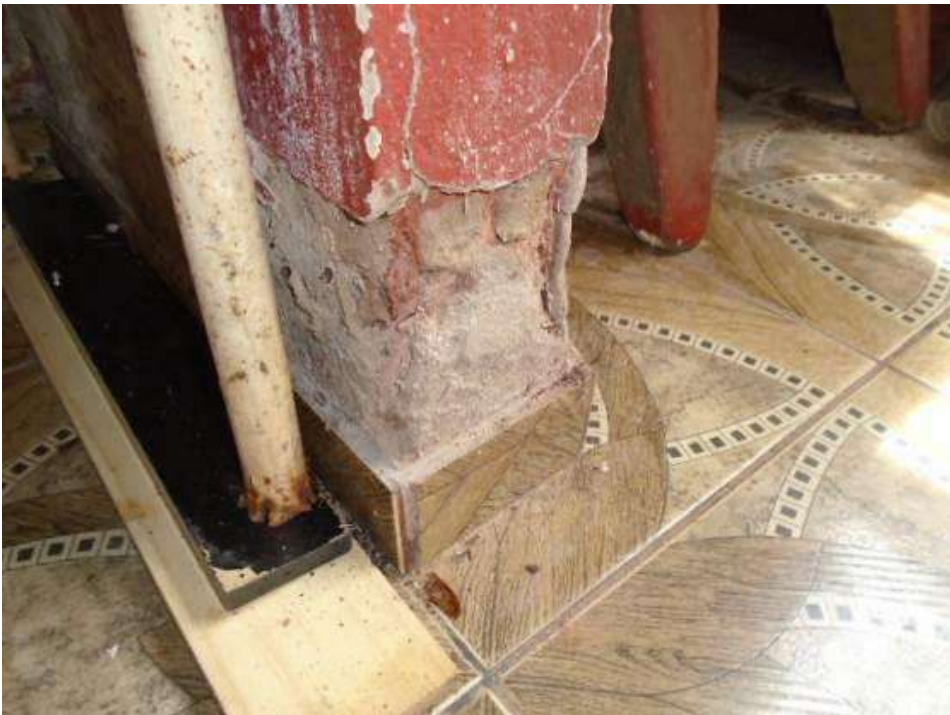
Figura 44 – Umidade prejudicando a integridade dos blocos de vedação.
