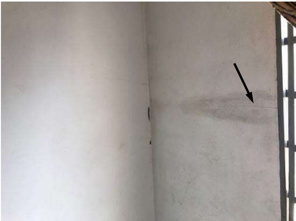
Figura 77 – Fissura com direcionamento de umidade para o interior da habitação.
