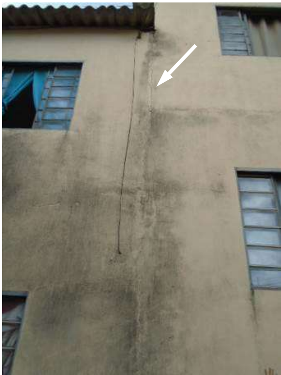
Figura 71 – Junta de dilatação entre prédios não foi devidamente executada no revestimento externo.
