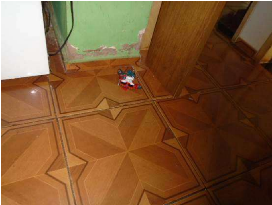
Figura 56 – Umidade junto ao piso no pavimento térreo.
