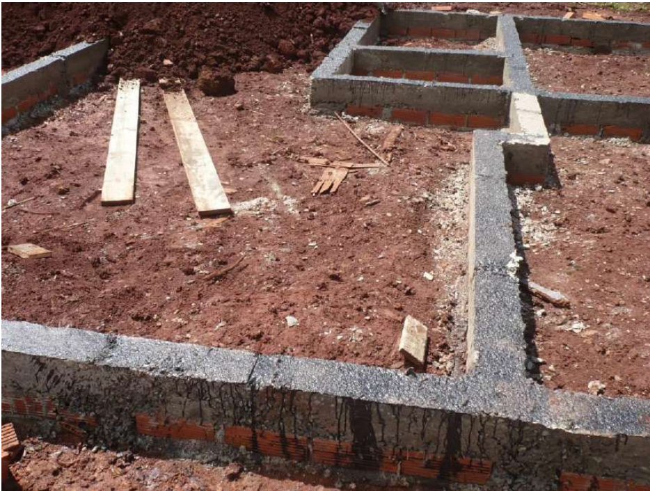
Figura 146 – Região onde foi executada a impermeabilização, porém com pouca eficiência pela baixa espessura.
