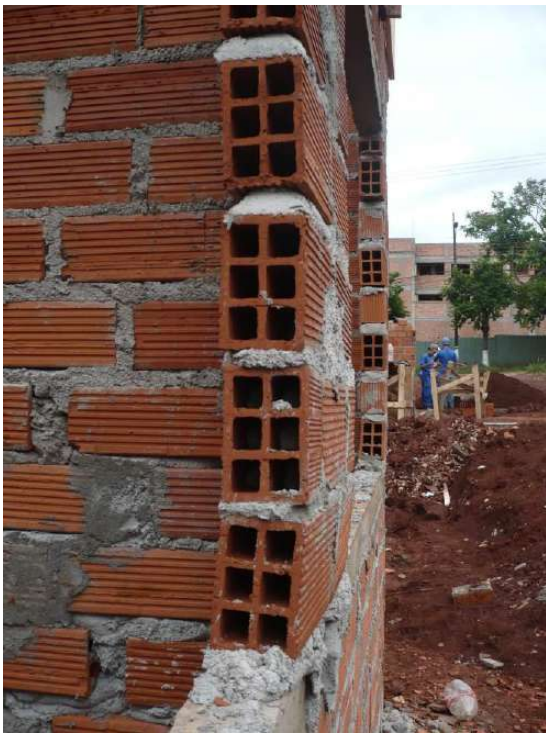
Figura 157 – Desaprumo da parede sendo a mesma a estrutura do prédio.
