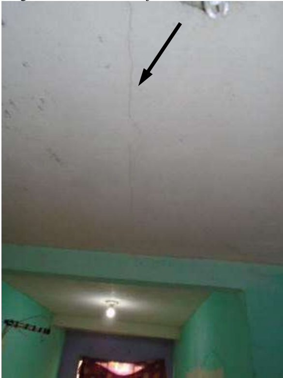
Figura 106 – Fissura no teto da laje da sala.
