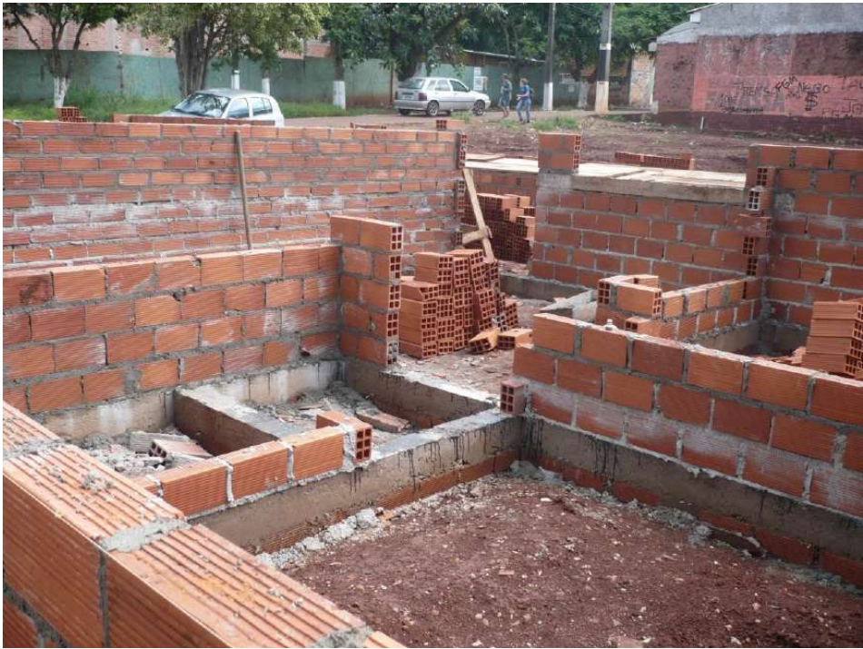
Figura 11 – Parede executada sobre viga de fundação de concreto armado, com altura próxima a 20 cm.
