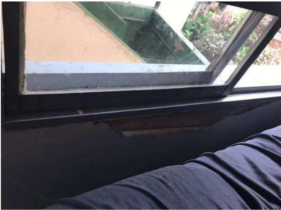
Figura 91 – Janela com infiltração no peitoril.
