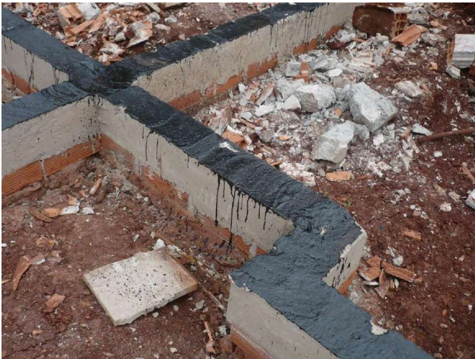
Figura 149 – Região onde foi feita a impermeabilização com espessura próxima da adequada.
