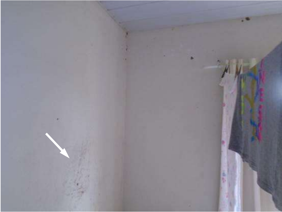
Figura 76 – Fissura na parte interna da habitação onde penetra umidade.
