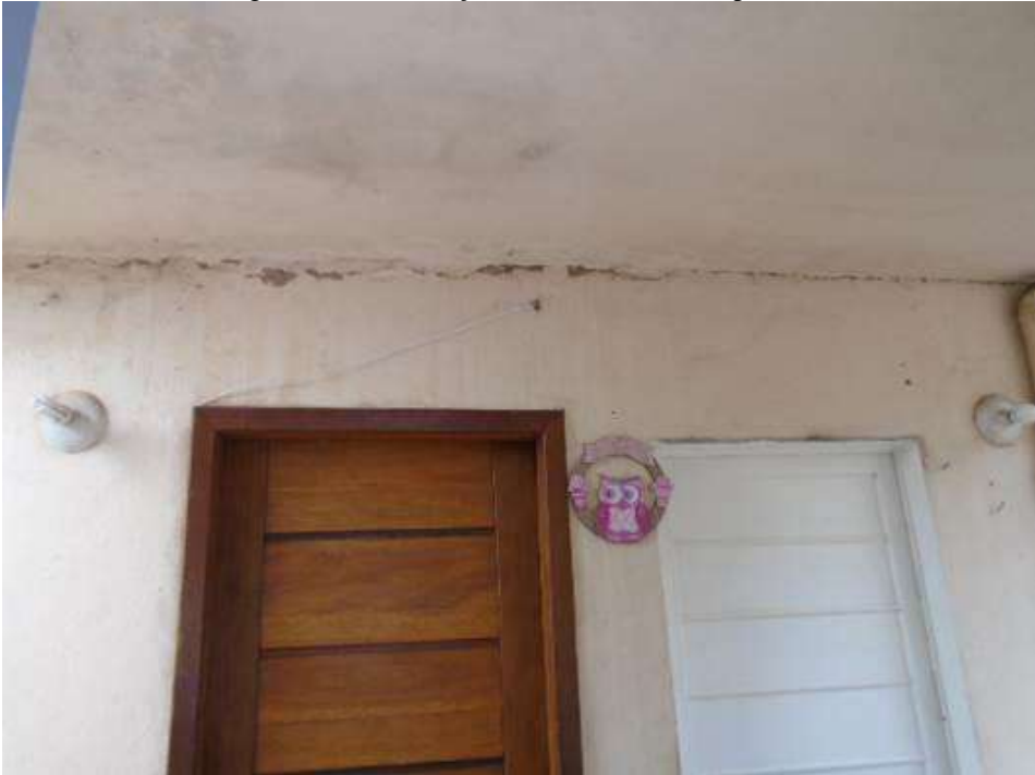
Figura 110 – Alteração nas dimensões das portas por parte dos moradores.
