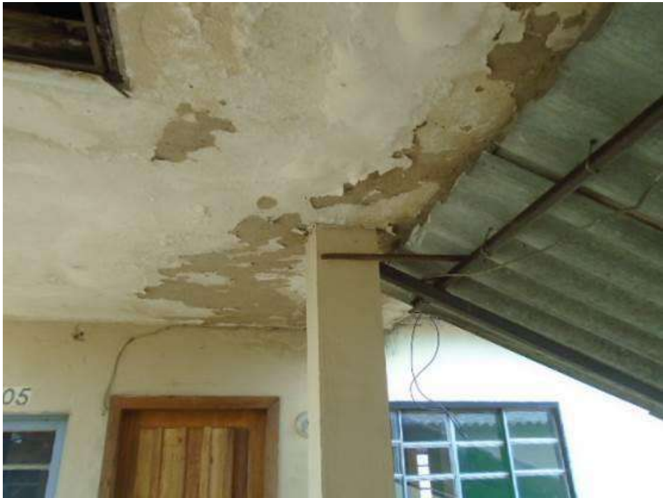
Figura 104 – Infiltração na laje sobre a escadaria.
