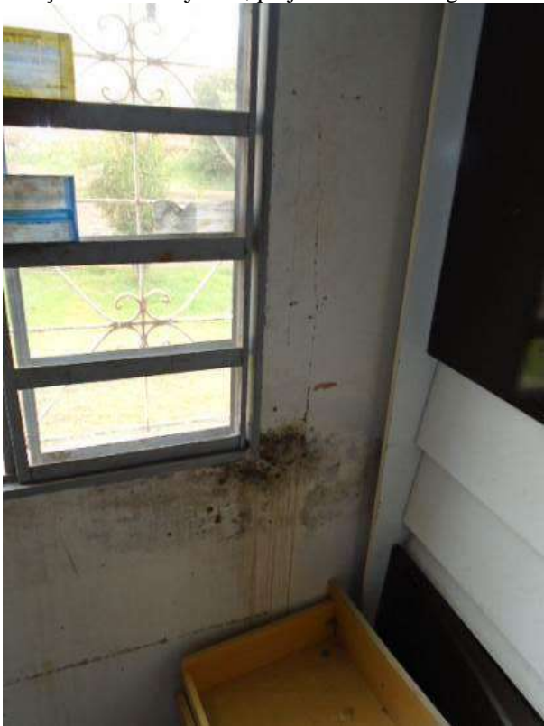
Figura 82 – Umidade no canto da janela.
