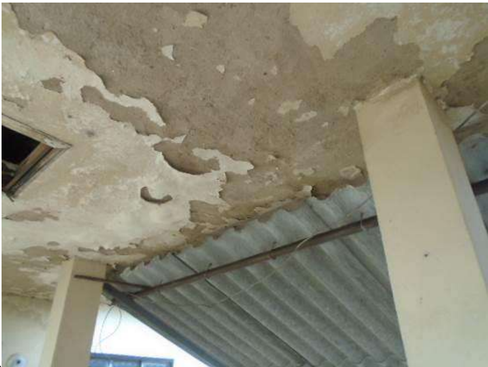
Figura 103 – Laje com significativa infiltração no teto da escadaria.
