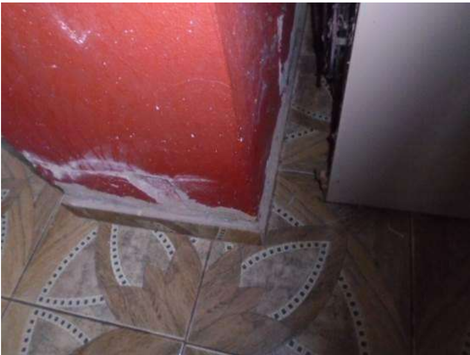
Figura 39 – Umidade ascendente na parede e revestimento com baixa resistência.
