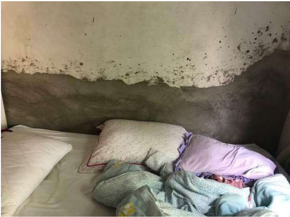
Figura 62 – Revestimento foi removido pelos moradores e executado novamente na parede.
