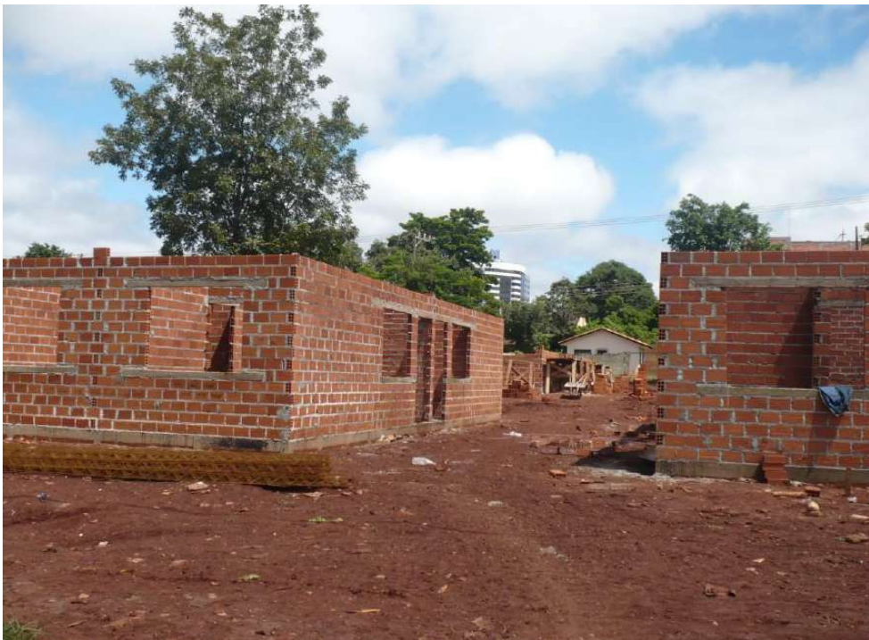
Figura 154 – Parte térrea em construção sem pilares de concreto armado.
