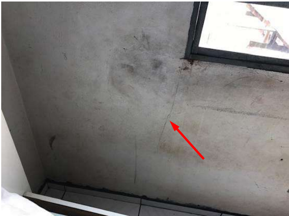
Figura 89 – Umidade e fissura no canto da janela.
