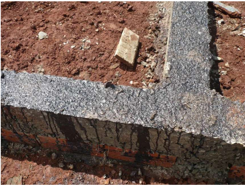
Figura 147 – Pouca eficiência pela baixa espessura da impermeabilização.
