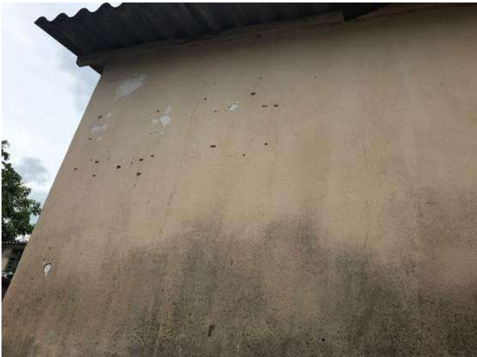
Figura 35 – Revestimento com baixa resistência na fachada.
