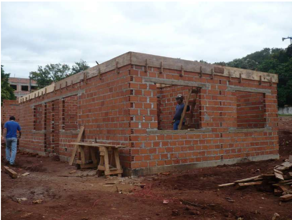
Figura 155 – Alvenaria do térreo executada com cinta de amarração executada em concreto armado.
