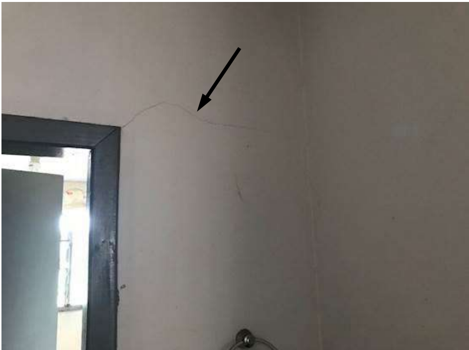
Figura 78 – Fissura horizontal no canto de uma das unidades.
