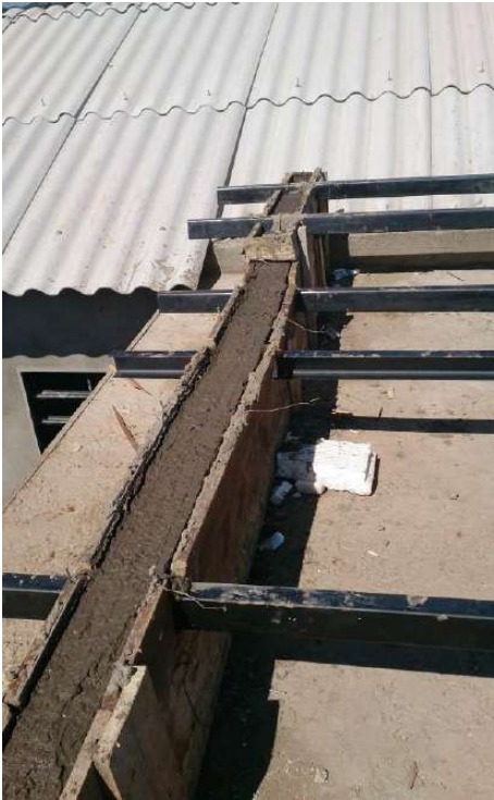
Figura 166 – Vigas metálicas no telhado para apoio da estrutura.
