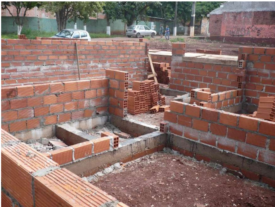
Figura 151 – Parede executada sobre viga de fundação.
