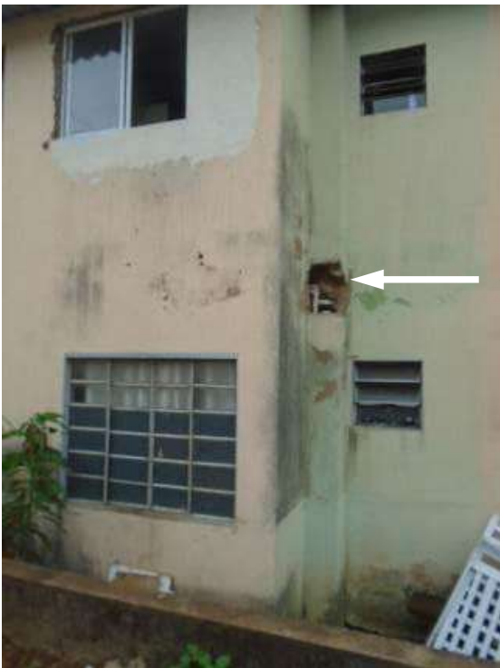
Figura 123 – Quebras nos shafts para correção de vazamentos.
