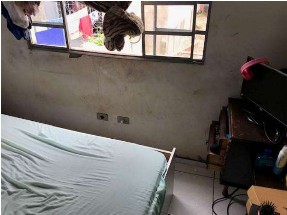
Figura 92 – Umidade ao redor da janela.
