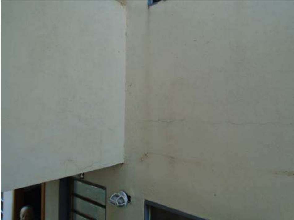
Figura 98 – Entre parede e escadaria não foi observada fissura.
