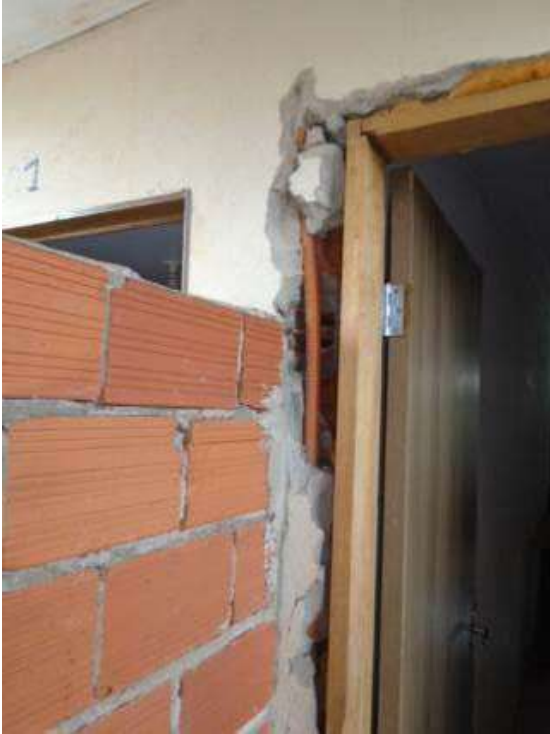
Figura 120 – Quebras nas paredes para instalação de portas.
