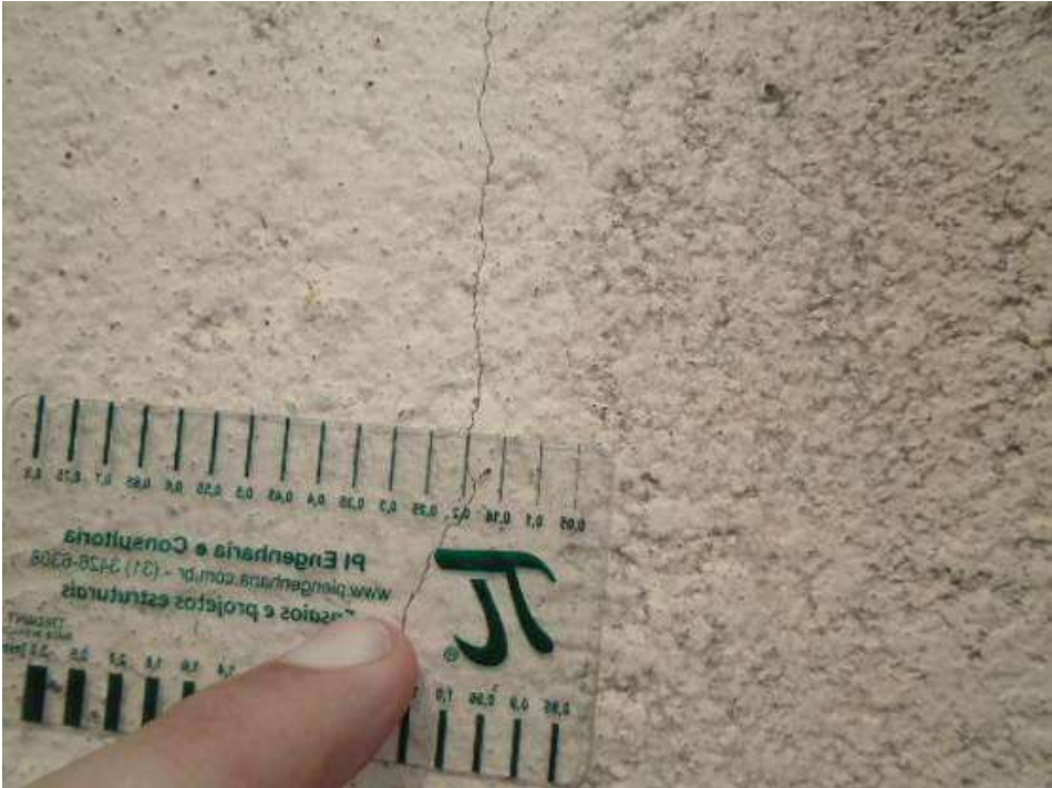
Figura 68 – Detalhe da fissura na parede do térreo.
