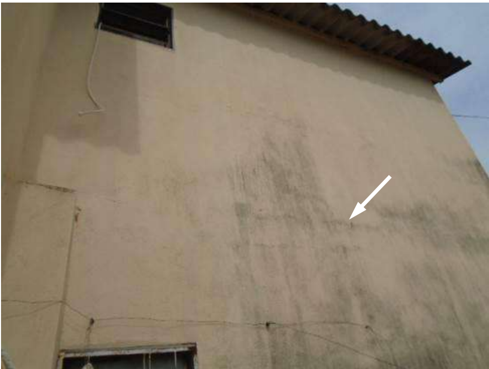
Figura 69 – Fissura horizontal no nível da laje.
