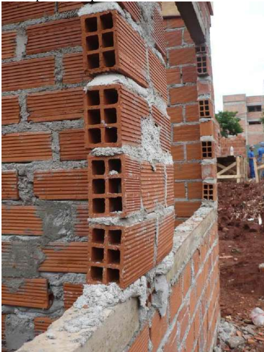
Figura 158 – Desaprumo da parede entre janelas onde esta região é muito importante estruturalmente.
