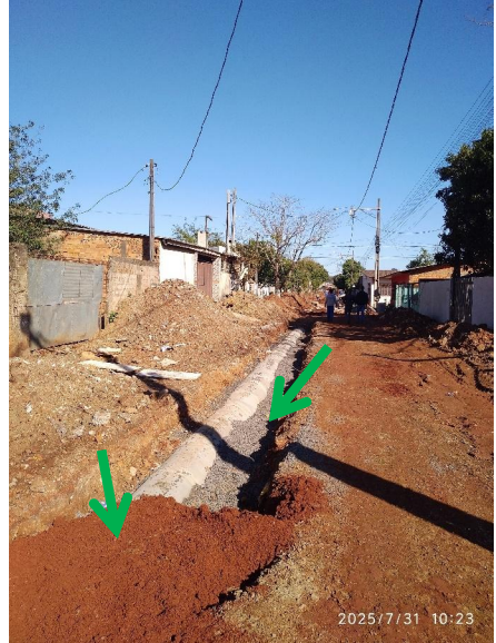
Imagem 20 - Reaterro com solo "novo"
