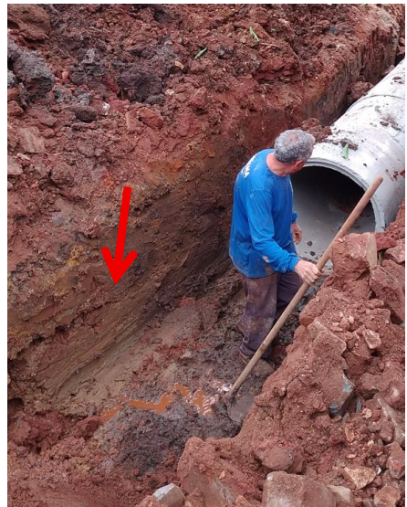
Imagem 26 – Imagem de 15/07/25, do início das escavações
