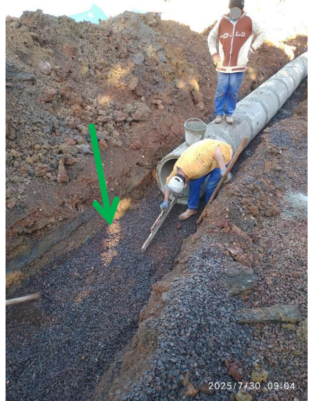
Imagem 16 – Tubos de concreto assentados sobre colchão de brita
