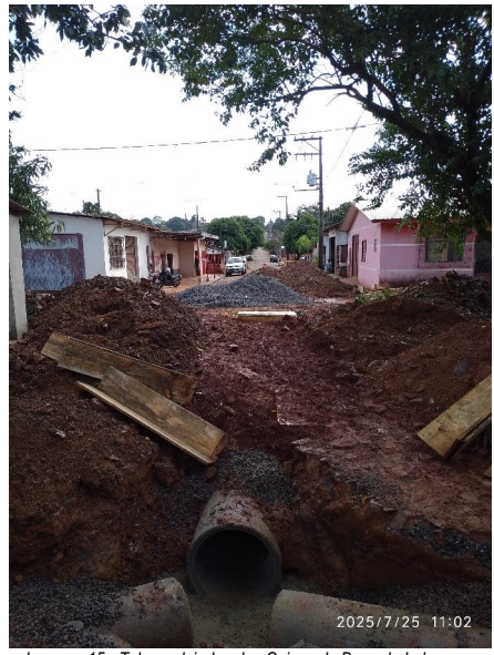
Imagem 15 - Tubos advindos das Caixas de Boca de Lobo para ligação com a galeria principal
