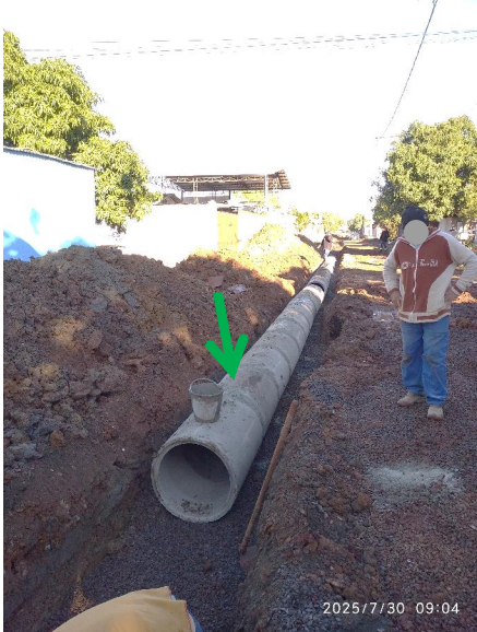
Imagem 18 – Emassamento dos tubos de concreto
