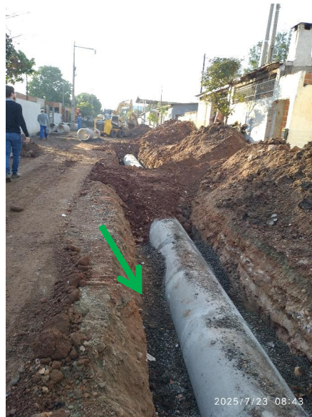
Imagem 10 – Assentamento dos tubos com brita até meia altura
