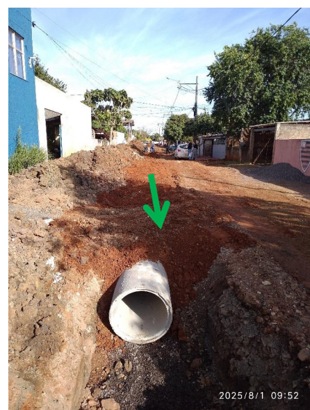
Imagem 22 - Reaterro com solo novo - Rua Rômulo Carbone
