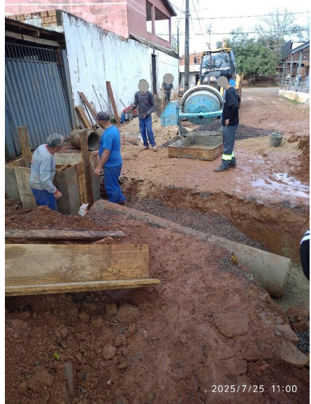
Imagem 14 - Execução das Caixas para Boca de Lobo
