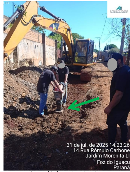
Imagem 21 - Compactação do reaterro
