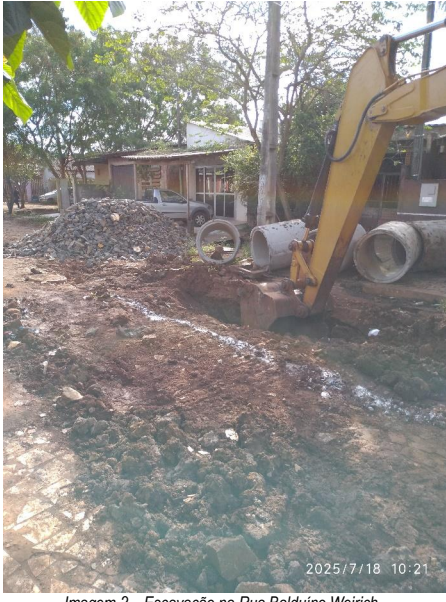
Imagem 2 – Escavação na Rua Balduino Weirich
