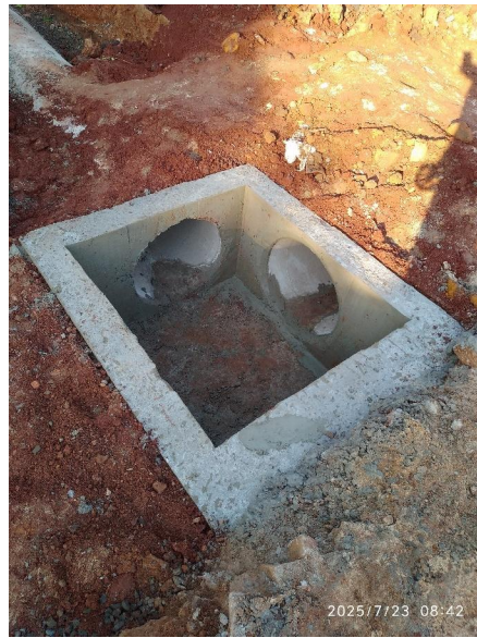
Imagem 9 – Caixa de Ligação e Passagem entre as Ruas Rômulo Carbone e Maria Bolwerk
