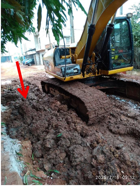
Imagem 1 – Escavação próxima ao local do PV-32
