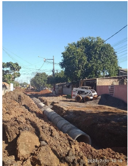
Imagem 19 – Assentamento do trecho final (próximo ao PV 12) da Rua Rômulo Carbone
