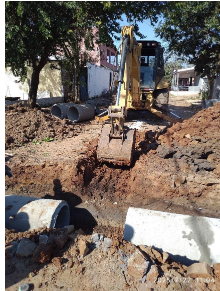
Imagem 7 – Abertura de vala para assentamento da galeria
