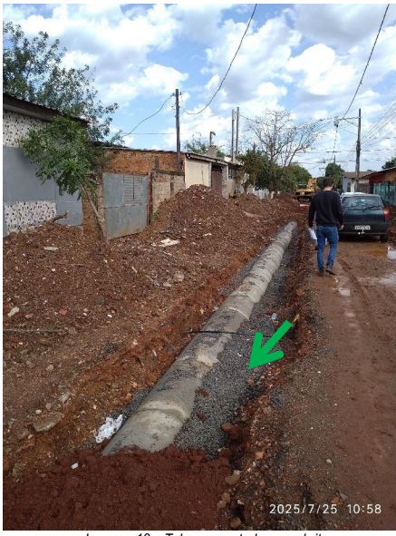
Imagem 13 – Tubos assentados com brita
