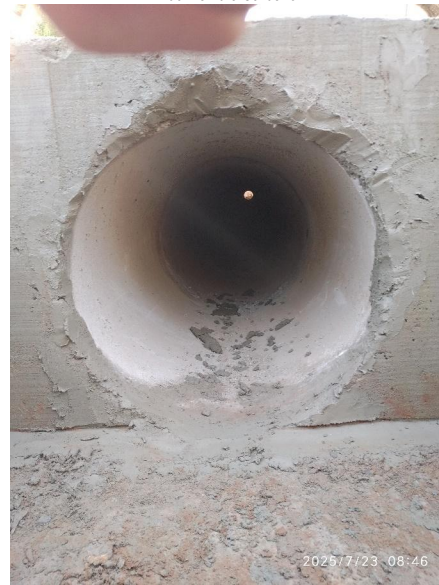
Imagem 12 – Ligação dos tubos de concreto com as CLP's e PV's
