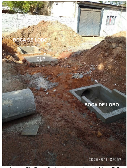
Imagem 23 - Execução das caixas para boca de lobo e CLP
