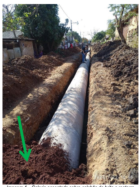
Imagem 4 – Galeria assentada sobre colchão de brita e reaterro com solo novo
