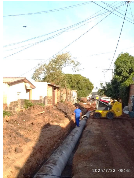
Imagem 11 – Brita sendo colocada até "meia altura" dos tubos – Rua Rômulo Carbone
