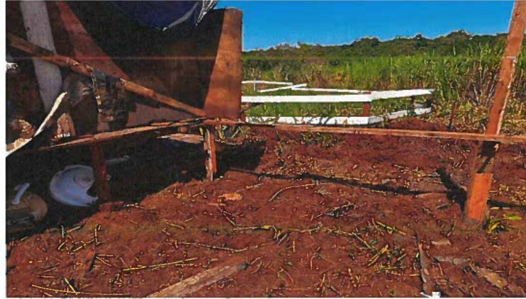
5º Barraco (Em construção)
