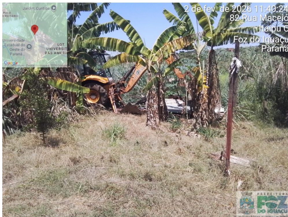
8 – Estrutura auxiliar demolida em 02 de fevereiro de 2026.
