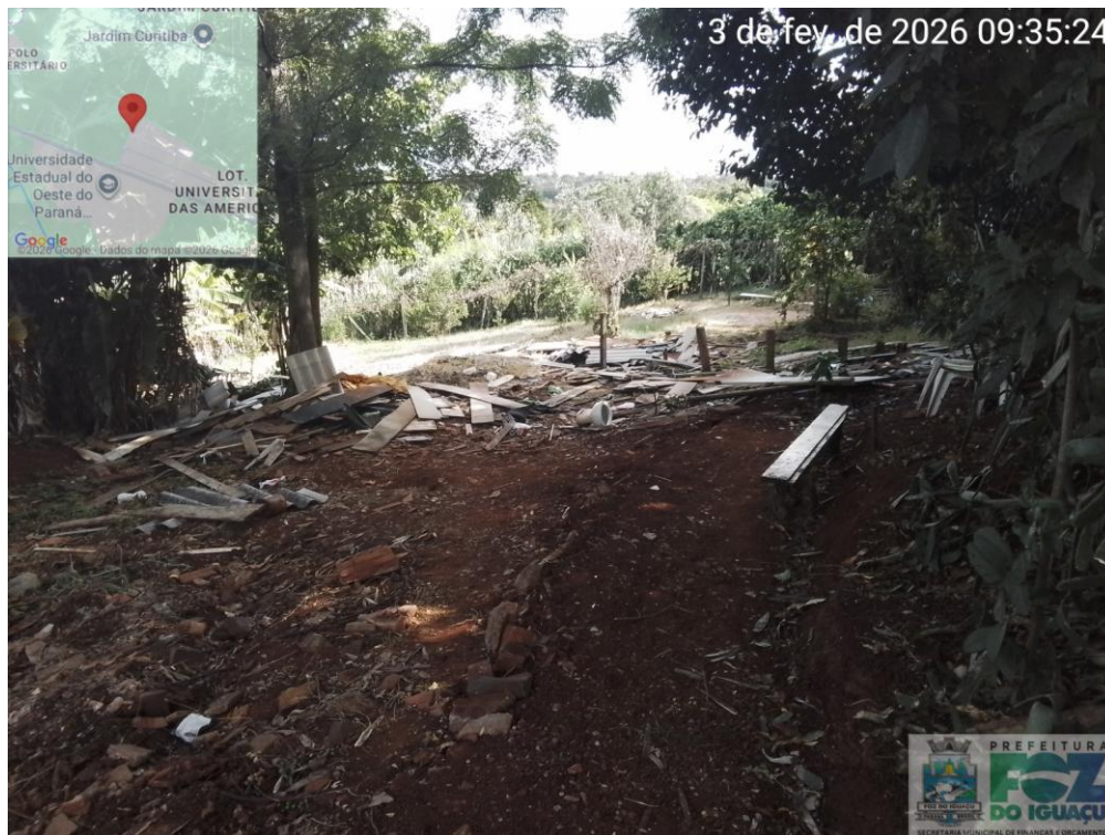
9 – Situação encontrada na vistoria do dia 03 fevereiro de 2026.
