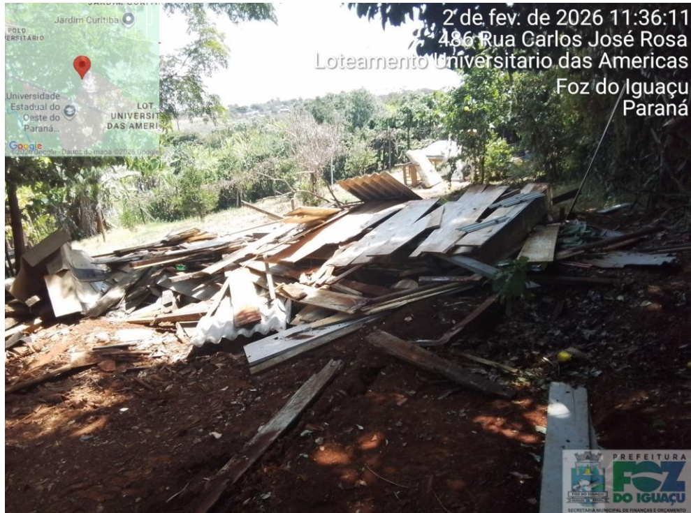
7 – Estrutura demolida em 02 de fevereiro de 2026.
