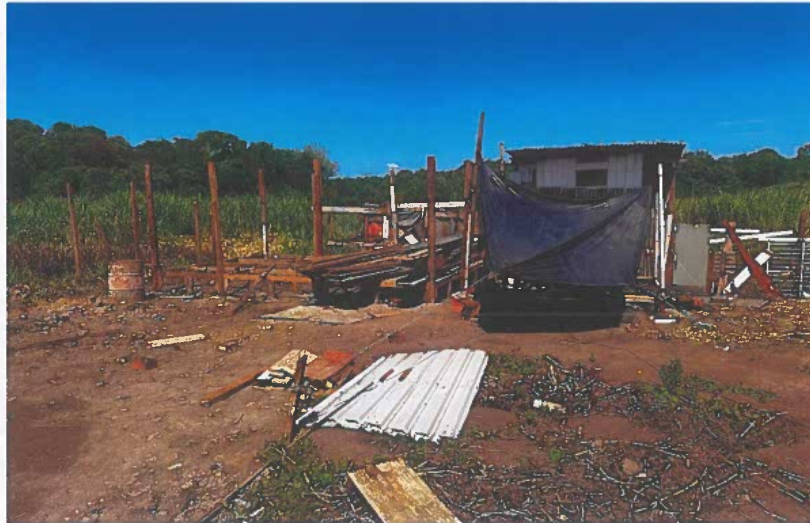
4º Barraco (Em construção/Lona)
